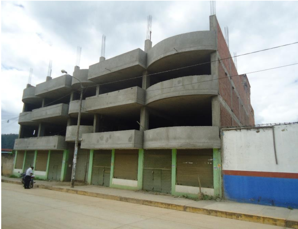
Figura 15 Inspección de Predio sin declarar
