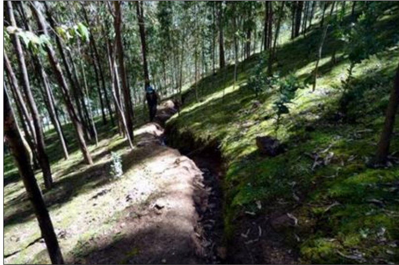
Fotografía 17: Canal para Evacuar Aguas Pluviales
