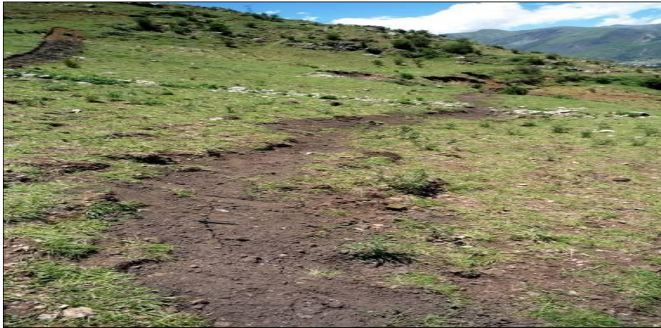
Fotografía 11: Manifestación de Grietas
