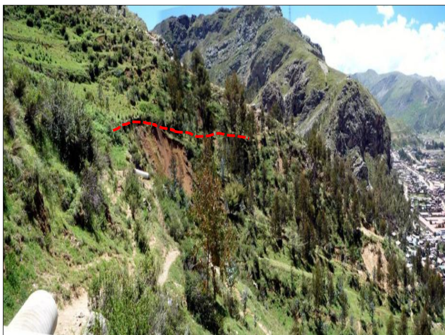
Fotografía 6: Zona de Arranque del Deslizamiento
