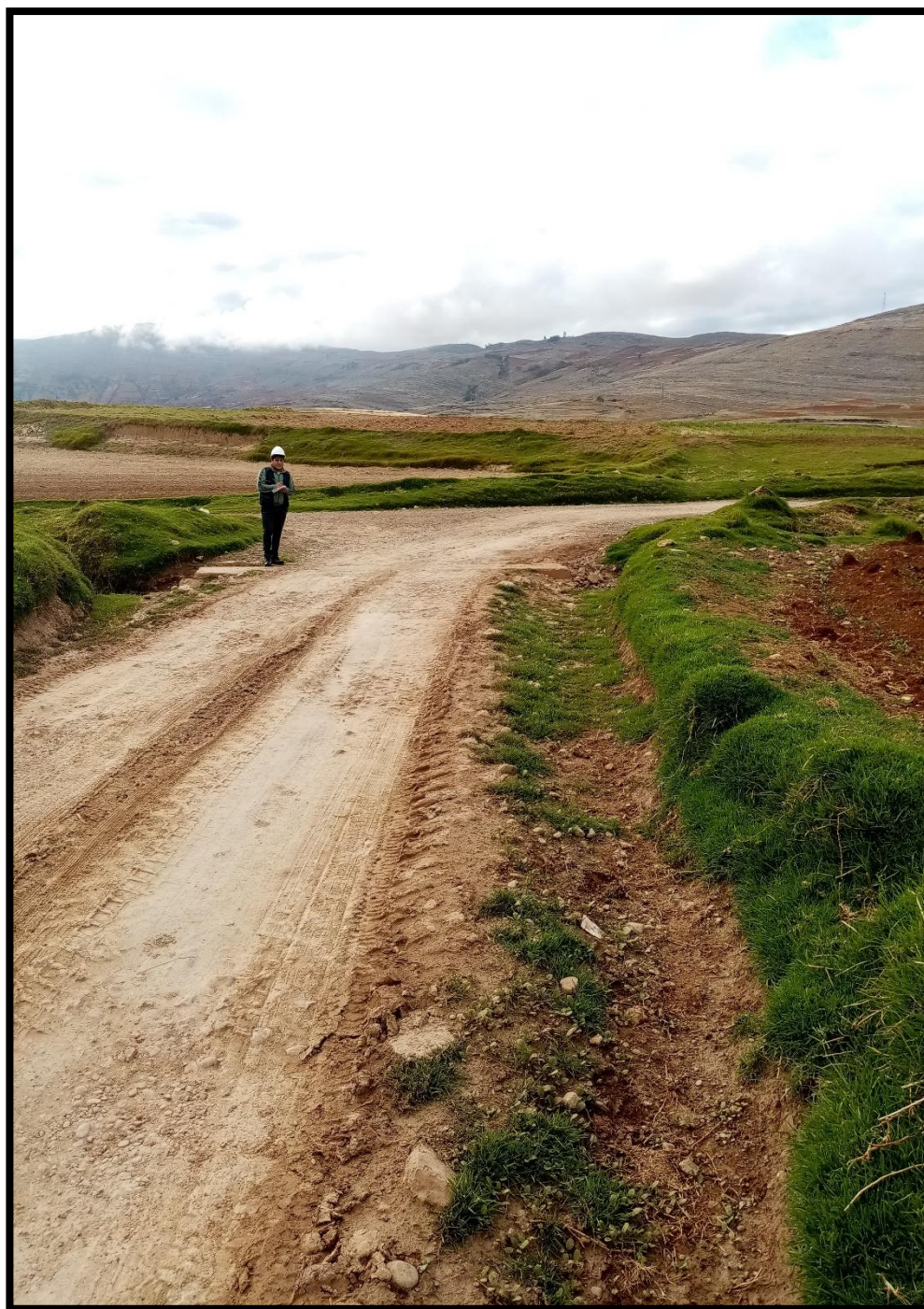
Foto 06: Cunetas en el tramo del camino vecinal Sapallanga-Huayucachi
