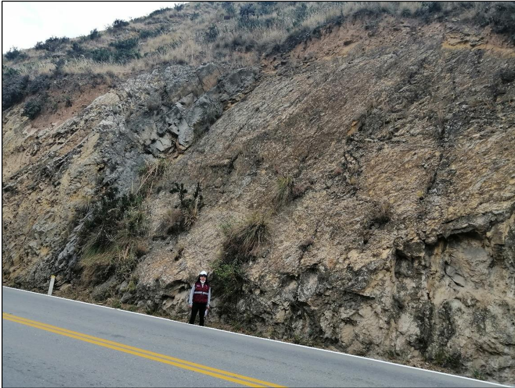
Fotografía 1. Vista de talud en la zona de estudio
