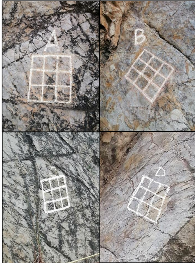
Fotografía 11. Zonas a tomar resistencia a compresión.
