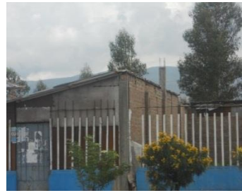
Edificación Analizada N° 5
