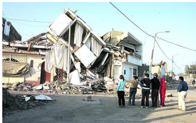
Figura N°8. Daño observado en las edificaciones luego del terremoto de Pisco del 15 de agosto del 2007.
