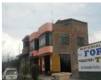
Edificación Analizada N° 1
