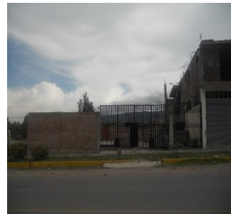
Edificación Analizada N°13
