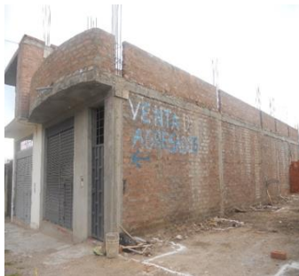
Edificación Analizada N°12
