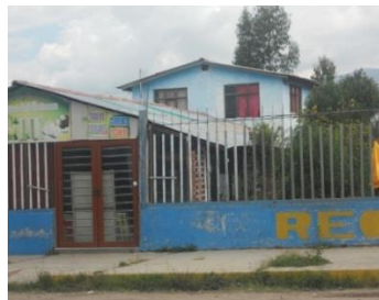
Edificación Analizada N° 5
