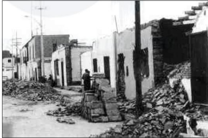
Figura N°9. Daños ocasionados en el Distrito de Chorrillos Lima luego del sismo del 3 de Octubre del 1974.
