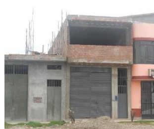
Edificación Analizada N° 2
