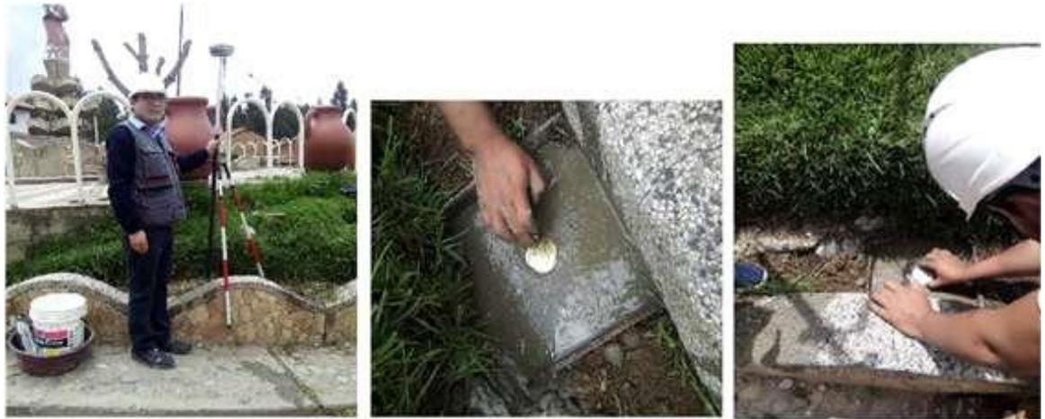
*Figura 35. Instalación de punto geodésico en el anexo de Paccha
