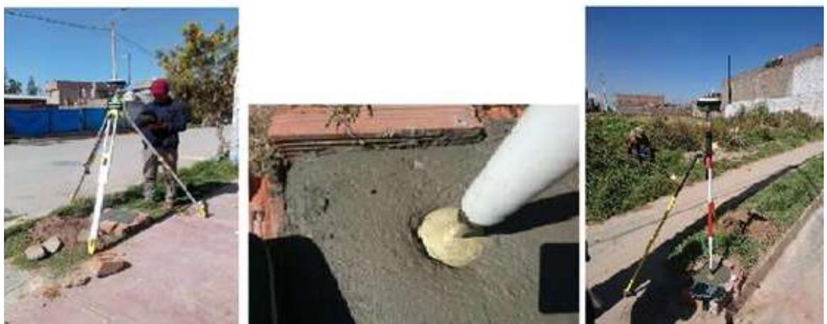
Figura 34. Instalación de punto geodésico en saños chico
