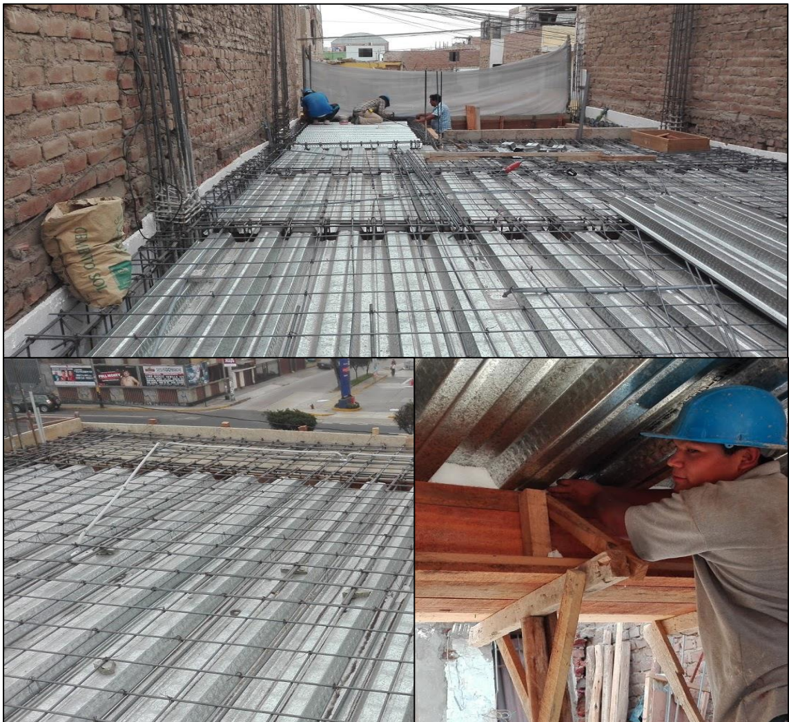
Figura N° 28: Colocación de planchas
