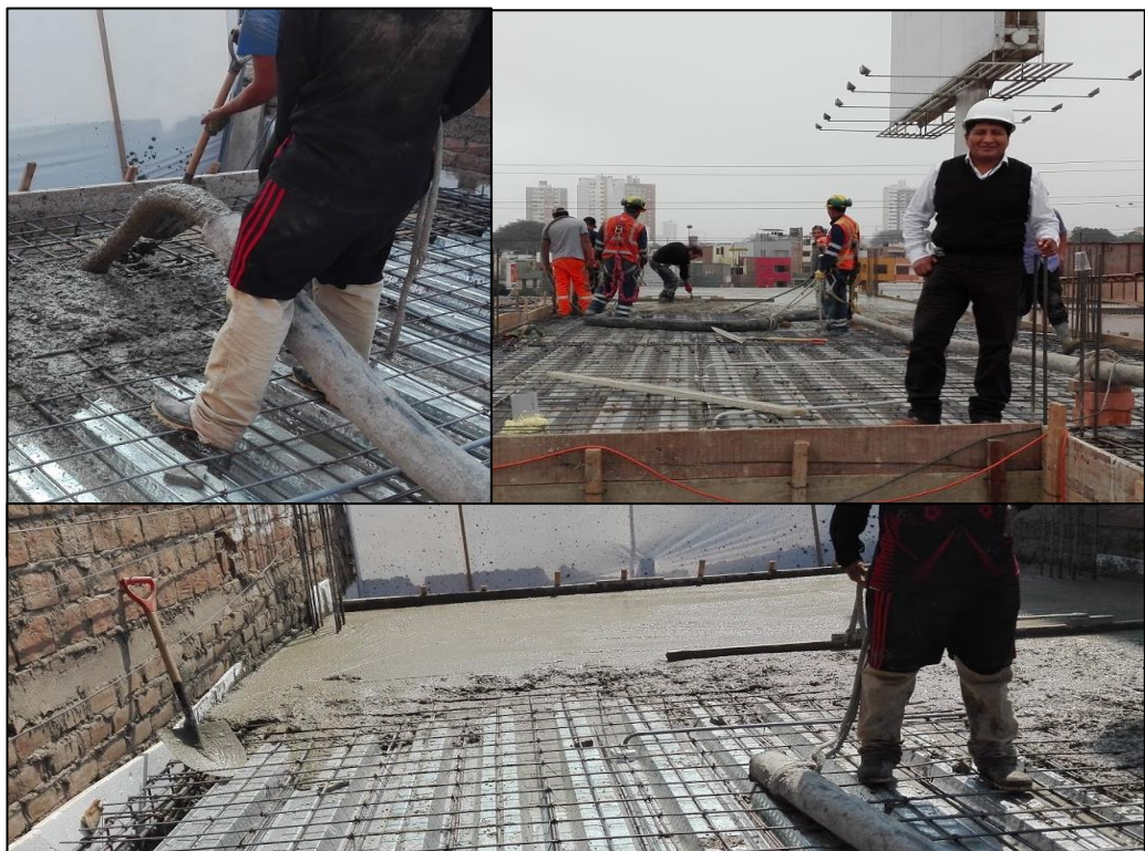
Figura N° 33: Vaciado de concreto
