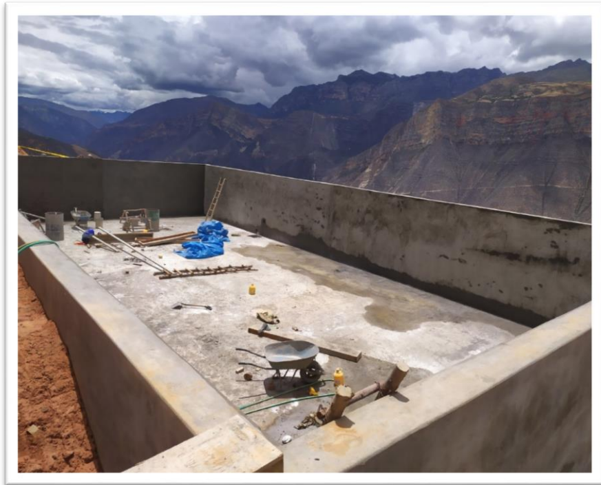
Imagen 05: Pulido e impermeabilización del reservorio.
