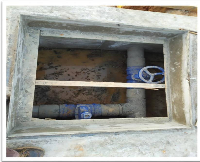
Imagen 07: Inspección de las válvulas.
