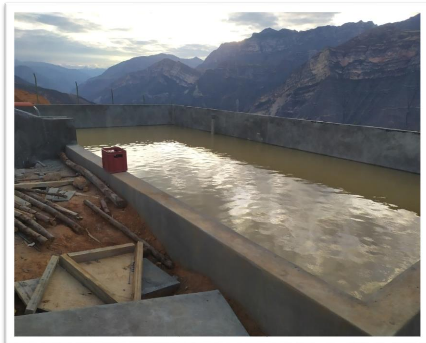
Imagen 06: Curado del concreto.
