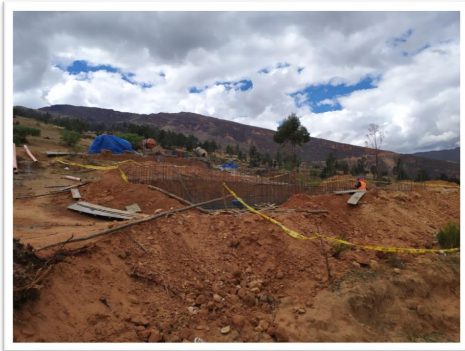
Imagen 01: Armado del reservorio.
