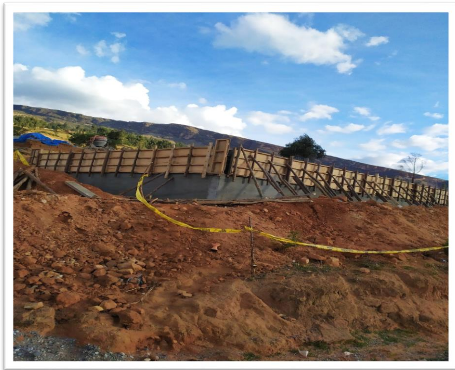
Imagen 03: Encofrado para él reservorio.
