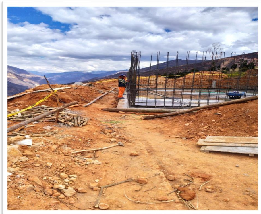
Imagen 02: Armado de placas para él reservorio.
