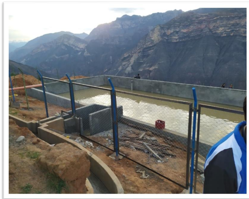
Imagen 08: instalación de cerco metálico.
