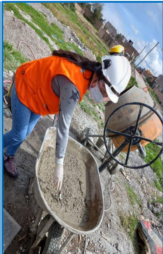
Collage fotográfico 06: Proceso de mezclado y control de temperatura del concreto.
