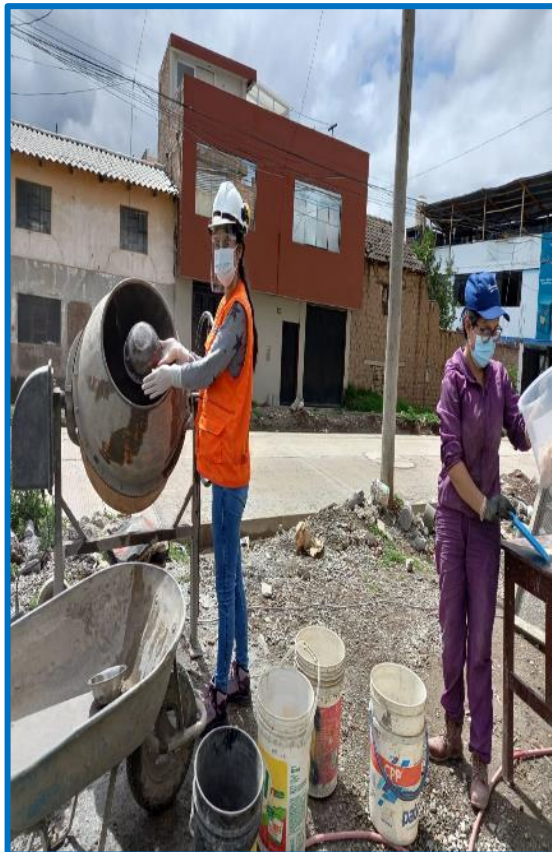
Collage fotográfico 06: Proceso de mezclado y control de temperatura del concreto.
