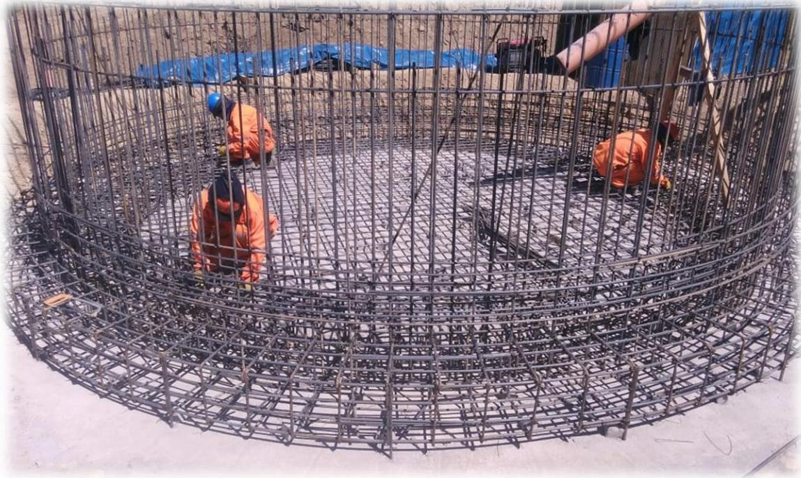
Proceso estructuración de la cimentación y losa del reservorio de 100m<sup>3</sup>.
