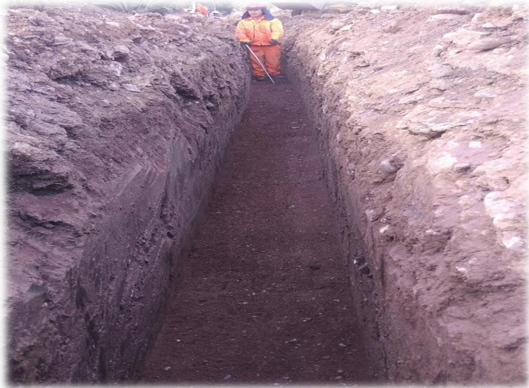
Vista del trabajo de tendido de cama de apoyo con material de préstamo.
