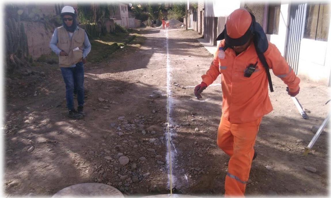
Proceso de trazo de las redes de alcantarillado sanitario, luego de haber culminado con la ejecución de las cámaras de inspección.
