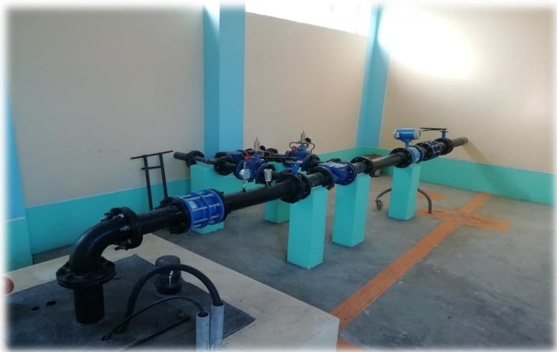
Vista del sellado de la bomba sumergible y accesorios dentro de la caseta de bombeo del sistema de abastecimiento de agua potable.
