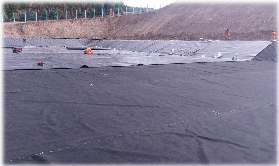
Proceso de colocación del geotextil y geomembrana, para la impermeabilización de las lagunas facultativas primarias y secundaria.
