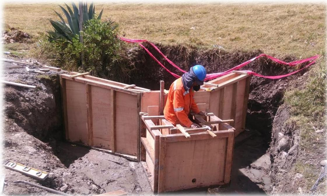
Proceso de encofrado de las obras de captación tipo ladera.
