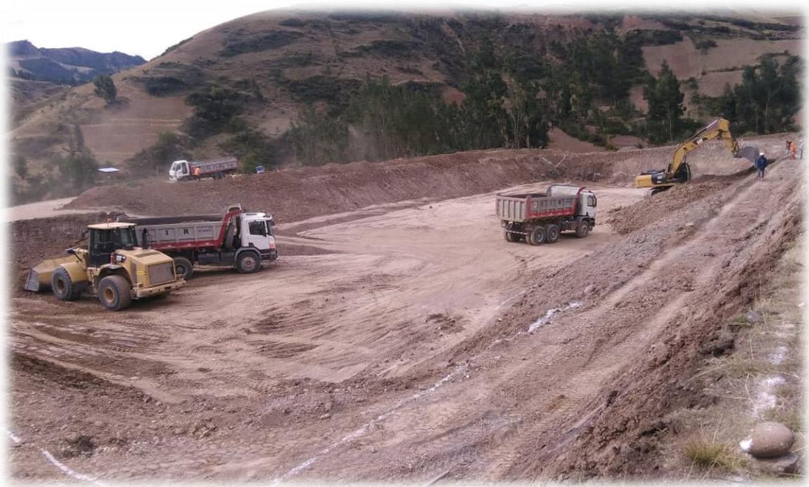
Trazo y excavación de las lagunas destinadas al sistema de tratamiento de aguas residuales – PTAR.
