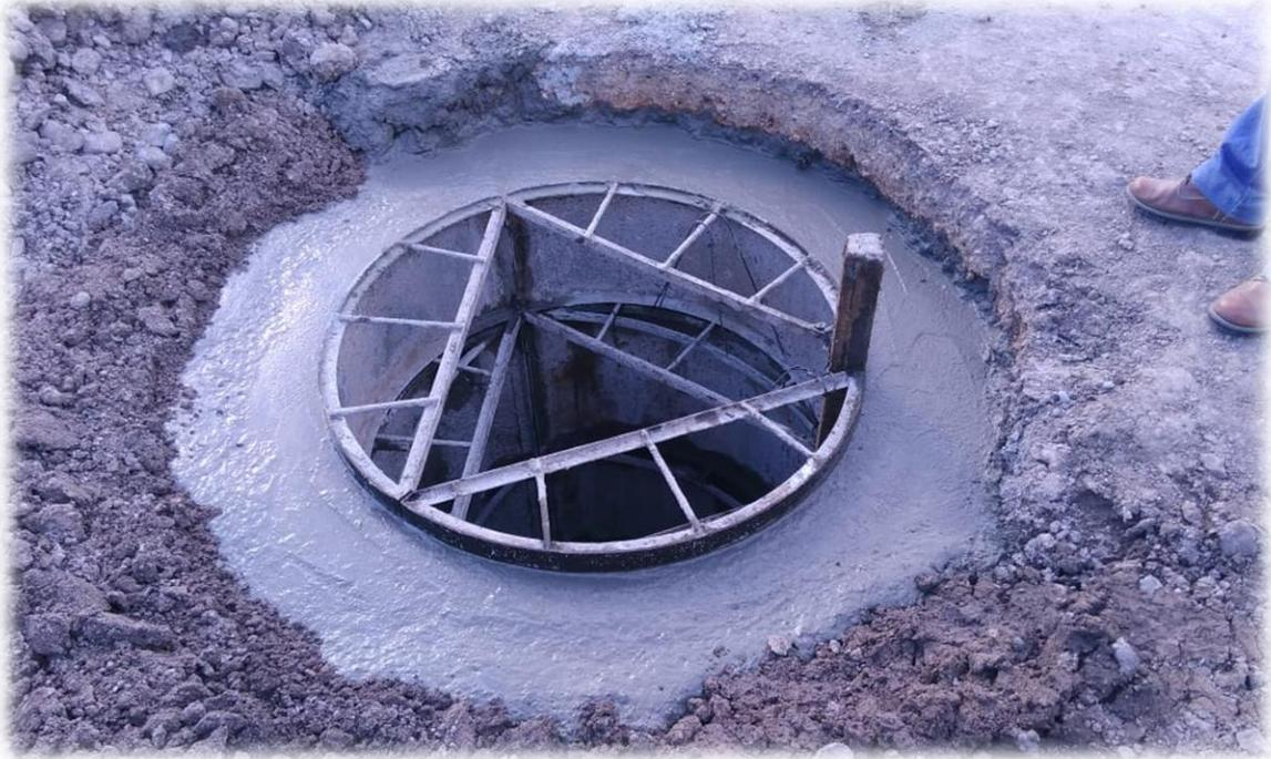
Proceso de encofrado y vaciado de las paredes de los buzones de inspección.
