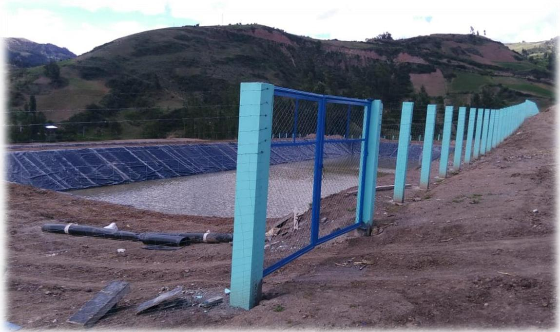
Vista del trabajo de colocación del cerco perimétrico de la planta de tratamiento de aguas residuales – PTAR.
