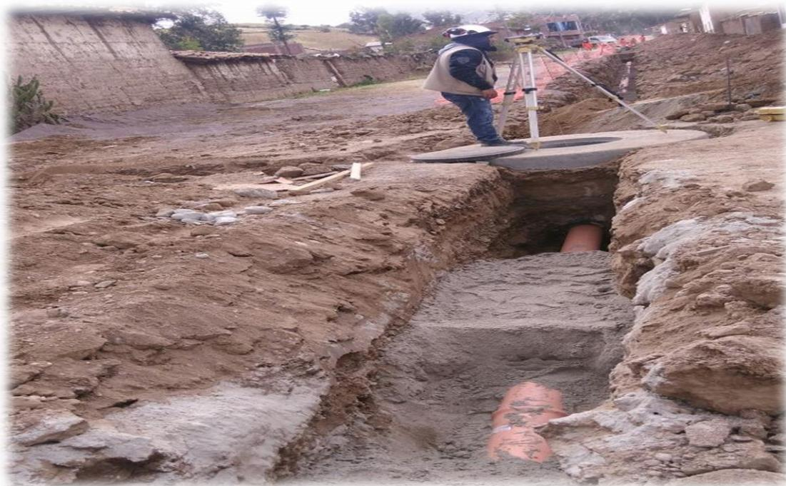
Relleno por encima de la clave de la tubería de las redes colectoras, a una altura de 0.30m, el cual se realizó con material de préstamo (arena gruesa).
