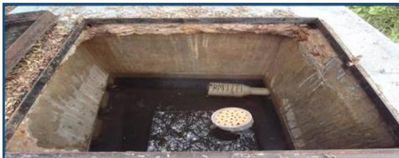
Figura 26 Válvulas de control y purga (vista de afuera)
