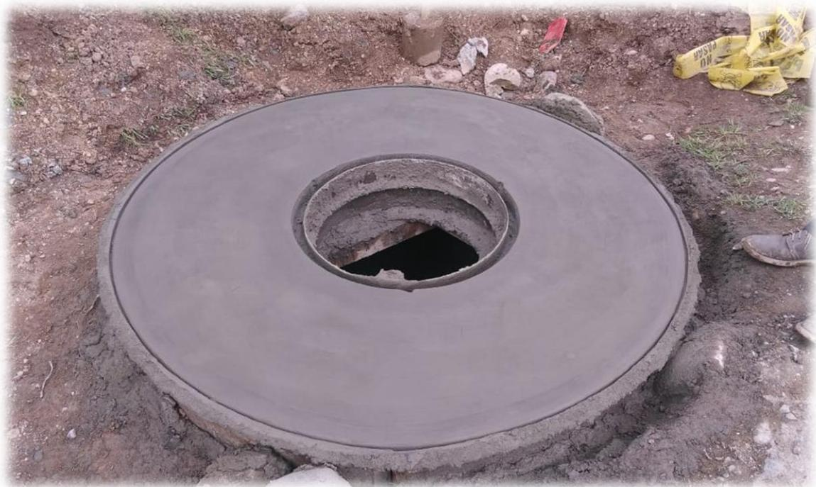
Vista típica del vaciado y acabado de la losa superior de las cámaras de inspección, el cual tiene un acabado barrido a fin de evitar accidentes.
