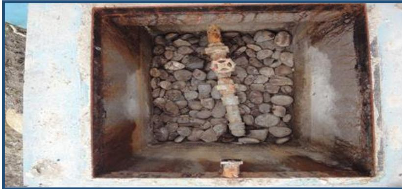
Figura 28 vista de planta de la válvula de control y purga
