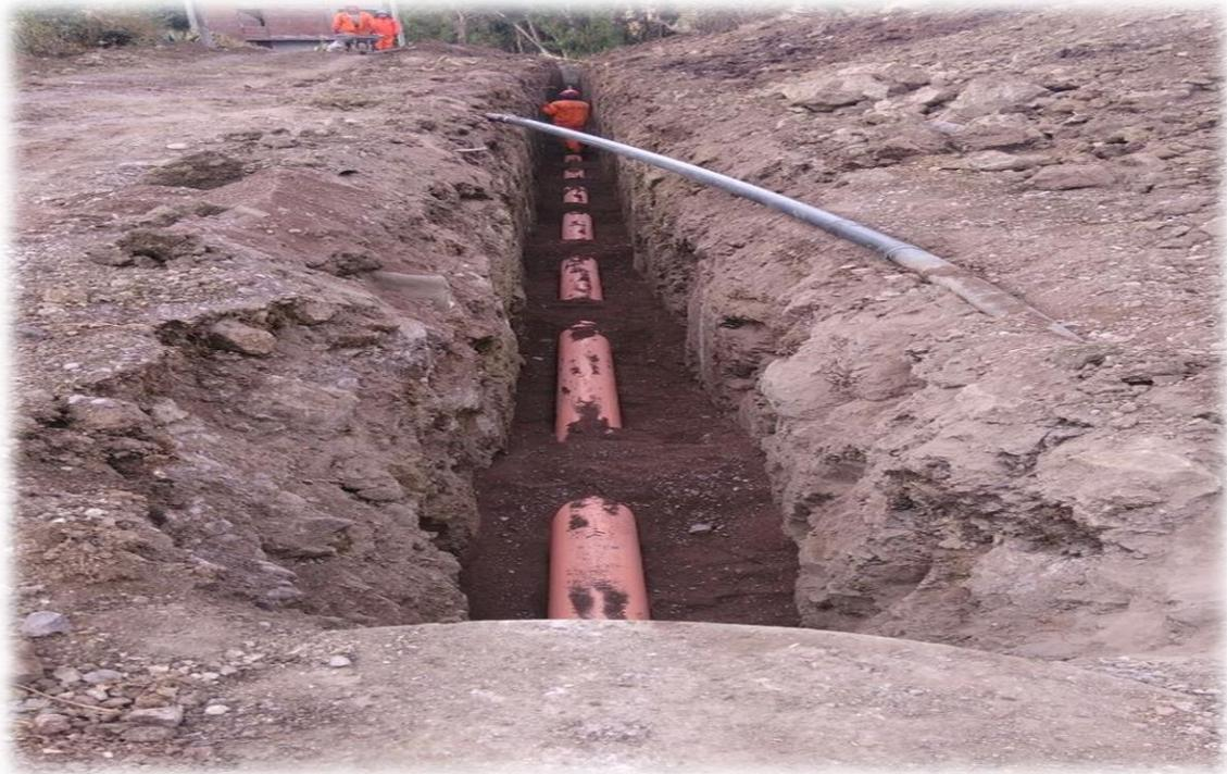
Vista del suministro e instalación de tuberías de 160mm y 200mm, respectivamente, luego de haber realizado el tendido de la cama de apoyo con el empleo de material de préstamo.
