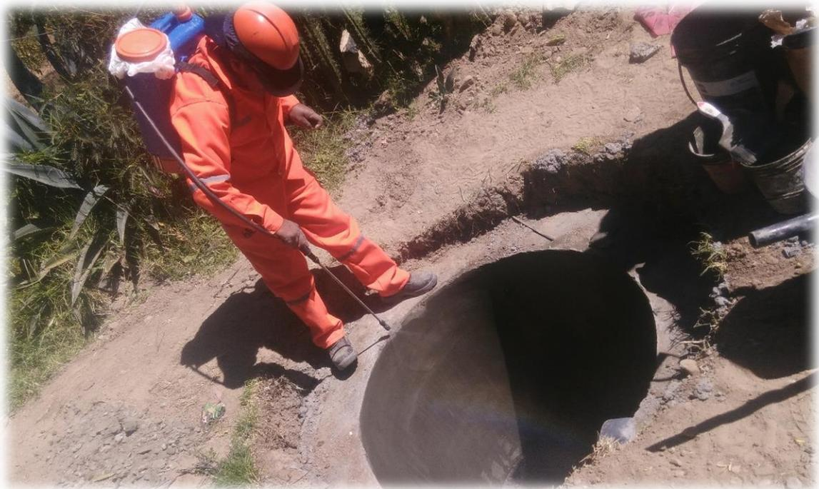
Proceso de curado de las obras de concreto mediante el empleo de aditivos.
