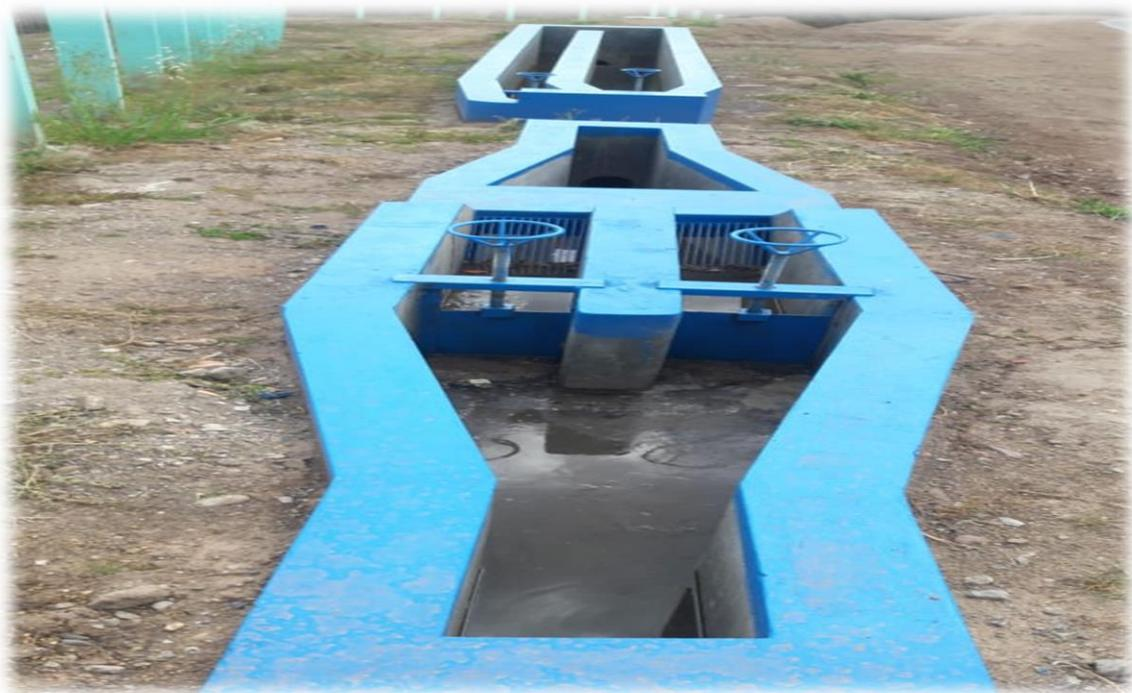
Vista longitudinal de las obras de arte de ingreso a la planta de tratamiento (cámara de rejillas, desarenados, vertedero y cámara repartidora de caudal).
