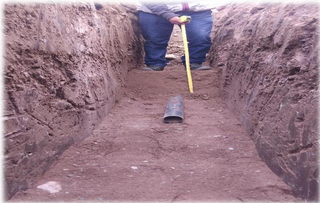
Se puede visualizar el control adecuado de la colocación de a cama de apoyo para las redes de agua potable, así como el recubrimiento con material de préstamo por encima de la clave de la tubería a una altura de 0.30m.
