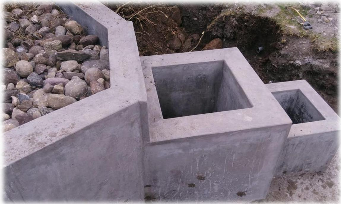
Vista típica de las obras de captación tipo ladera luego de haber realizado los trabajos de mantenimiento y reconstrucción.
