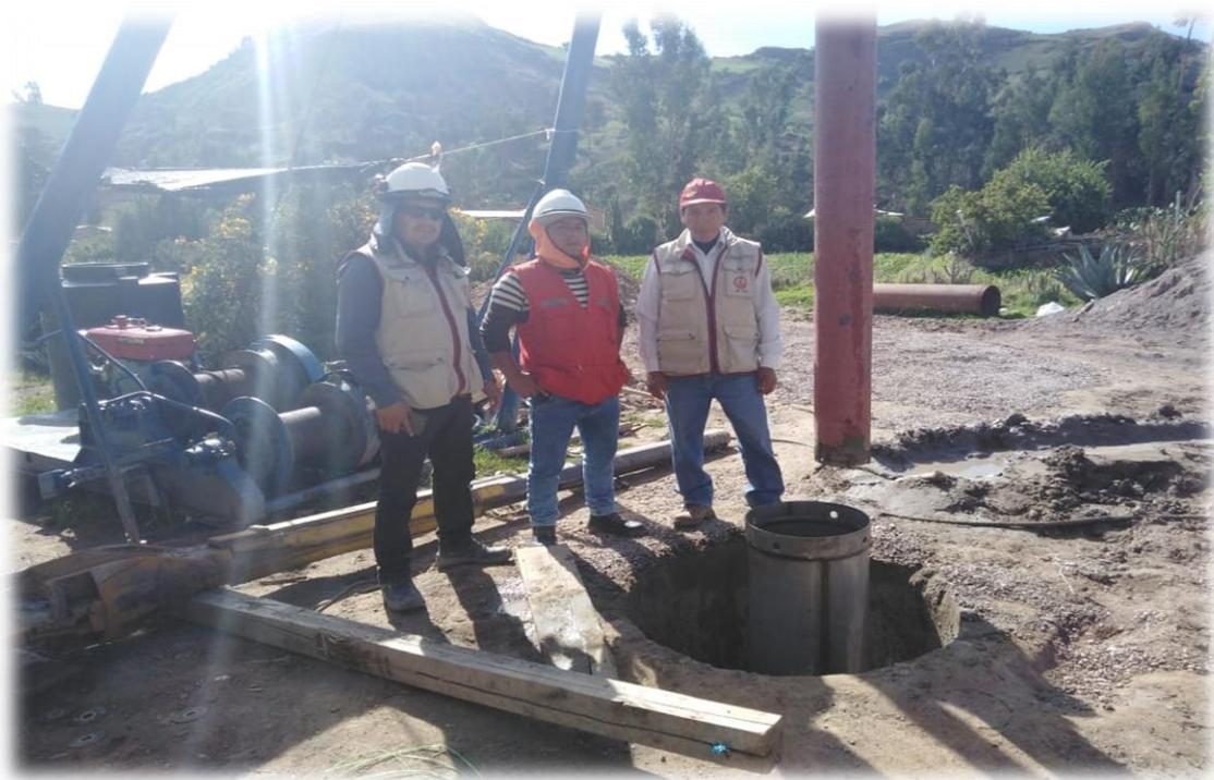
Proceso de perforación de pozo de agua, para el abastecimiento de agua potable por bombeo, el cual alcanza una altura de 35m. de profundidad.
