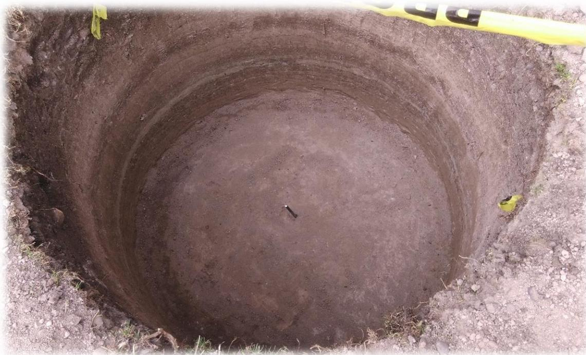
Excavación de las cámaras de inspección, el cual tiene un diámetro de 1.50 m.
