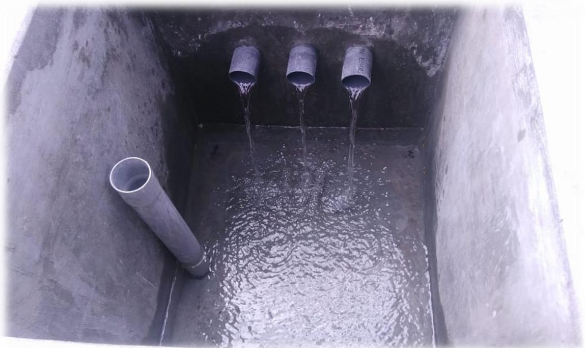
Se aprecia la salida de agua captada hacia la cámara húmeda, luego de haber culminado la estructura de captación tipo ladera.
