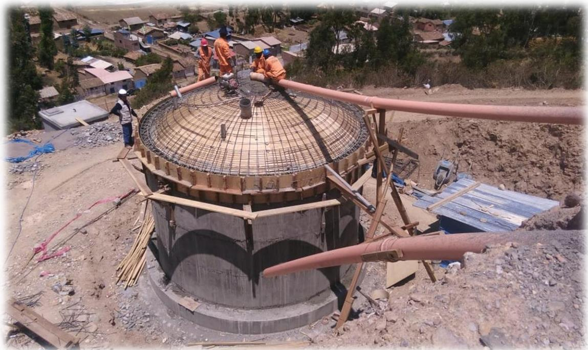
Proceso de encofrado, armad de acero y posterior vaciado de la viga principal y cúpula del reservorio de 100m<sup>3</sup>.
