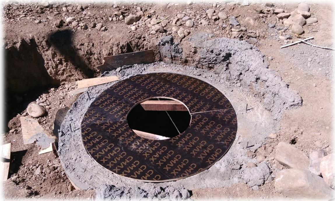
Encofrado de la losa superior de las cámaras de inspección y/o buzones.
