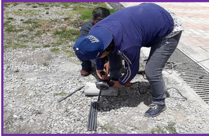
FOTO N°1: CORTANDO LOS ACEROS A 40 CM
