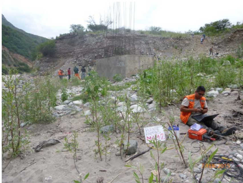
Fotografía 04: Se aprecia la toma de datos correspondiente al MAM-02. Puede apreciarse el tendido de cables y la conexión al equipo para la adquisición de las señales sísmicas.
