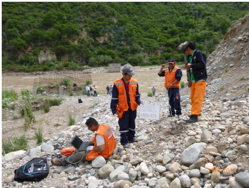
Fotografía 08: Zona de trabajo de la línea LRS-04. Se puede apreciar el tendido de los cables.
