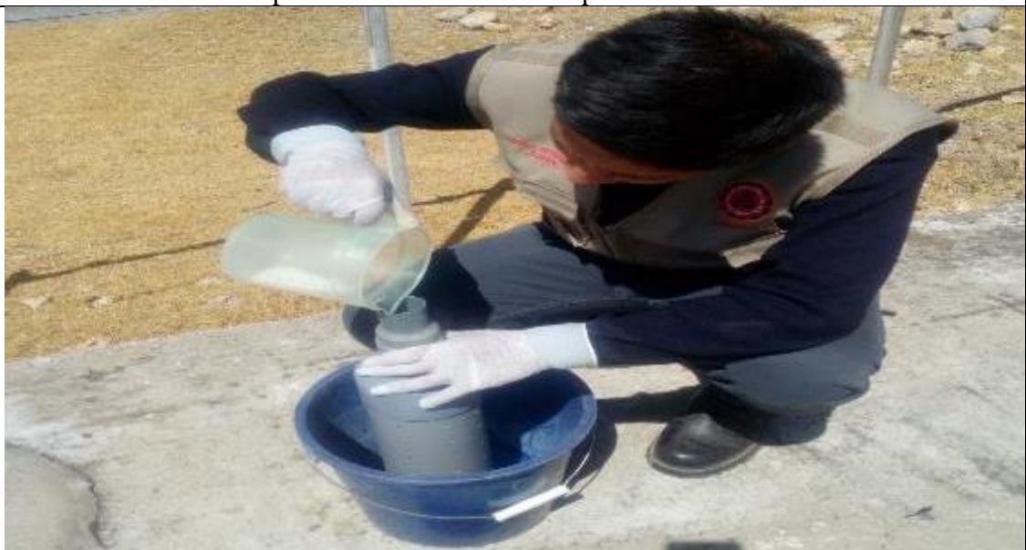
Preparación para la cloración del agua del reservorio
