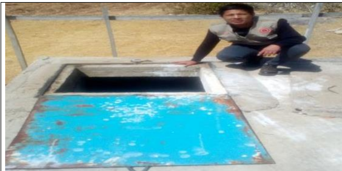
Tapa metálica del reservorio
