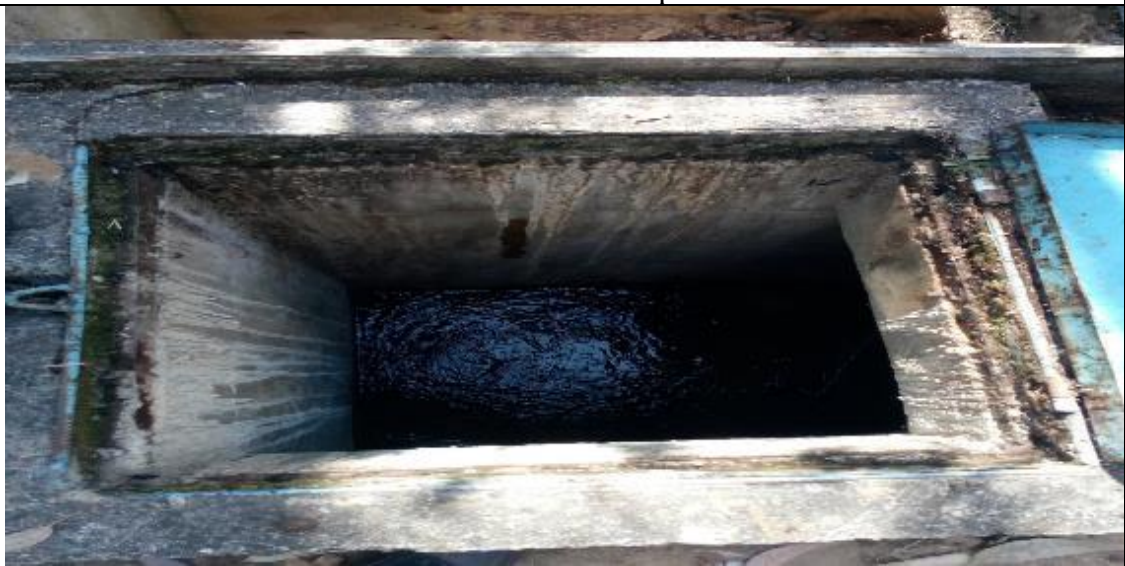
Caja de la captación
