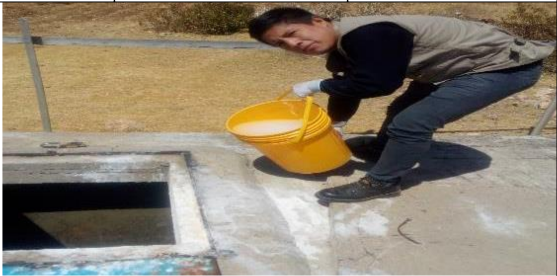
Limpieza del reservorio con hipoclorito de sodio
