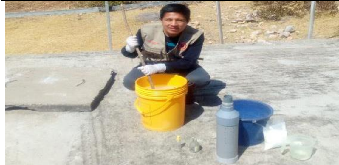
Preparación de la solución madre con hipoclorito de sodio
