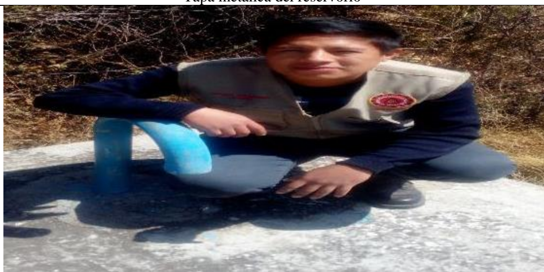
Tubería de ventilación
