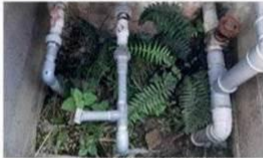
Caseta de válvulas reservorio existente
