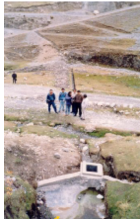
FIGURA N° 06 Captación captada por manantiales en ladera.
