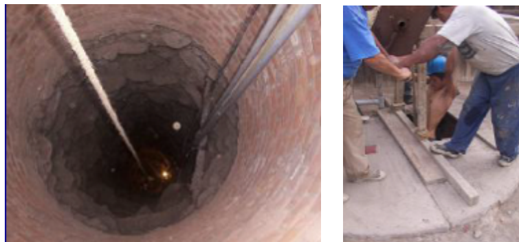
FIGURA N° 04 Captación captada por pozos excavados
