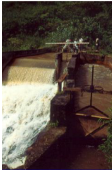
FIGURA N° 02 Captación captada por un río.
