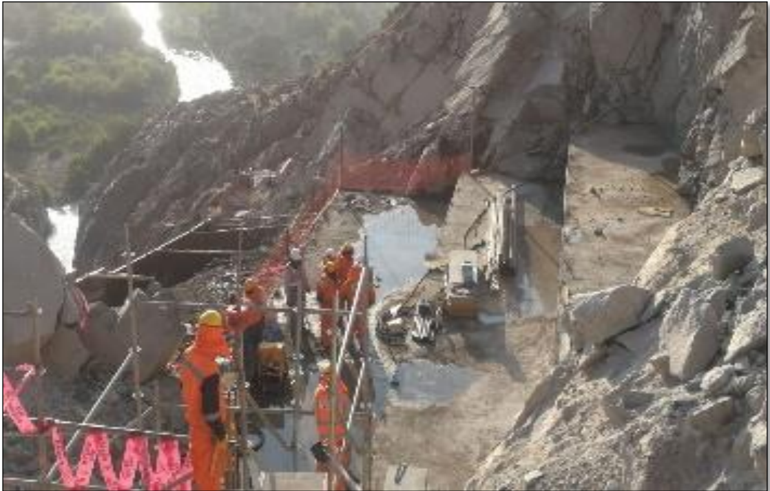
Imagen 12 Inyecciones de agua cemento en pilar 7 FUENTE: Elaboración propia
