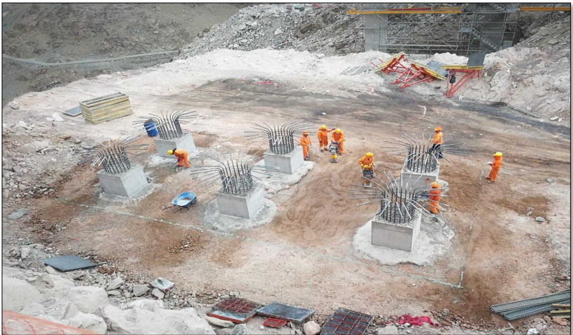
Imagen 4 Terminación de pilotes en pilar 9 FUENTE: Elaboración propia
