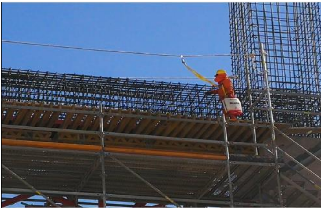
Imagen 14 Proceso constructivo de pilar 9 FUENTE: Elaboración propio
