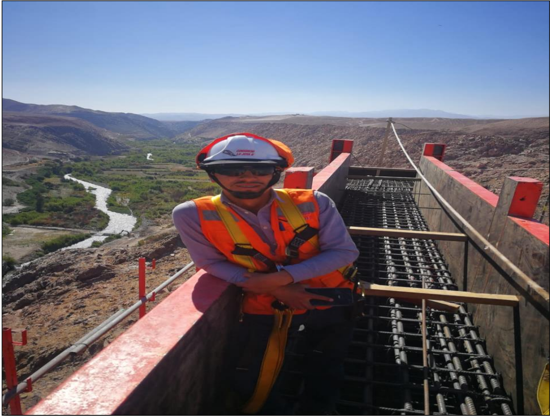
Imagen 15 Verificación de encofrado y acero de pilar 9 FUENTE: Elaboración propia
