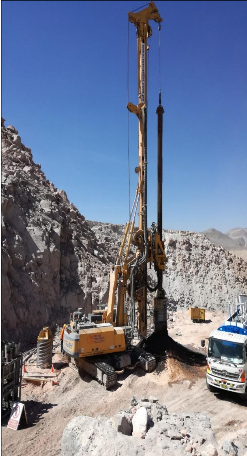
Imagen 1 Perforación para pilotes en pilar 9 con pilotera FUENTE: Elaboración propia
