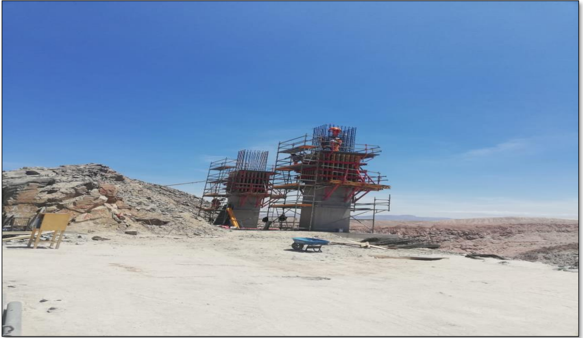
Imagen 7 Uso de encofrado trepante en pilar 1 FUENTE: Elaboración propia
