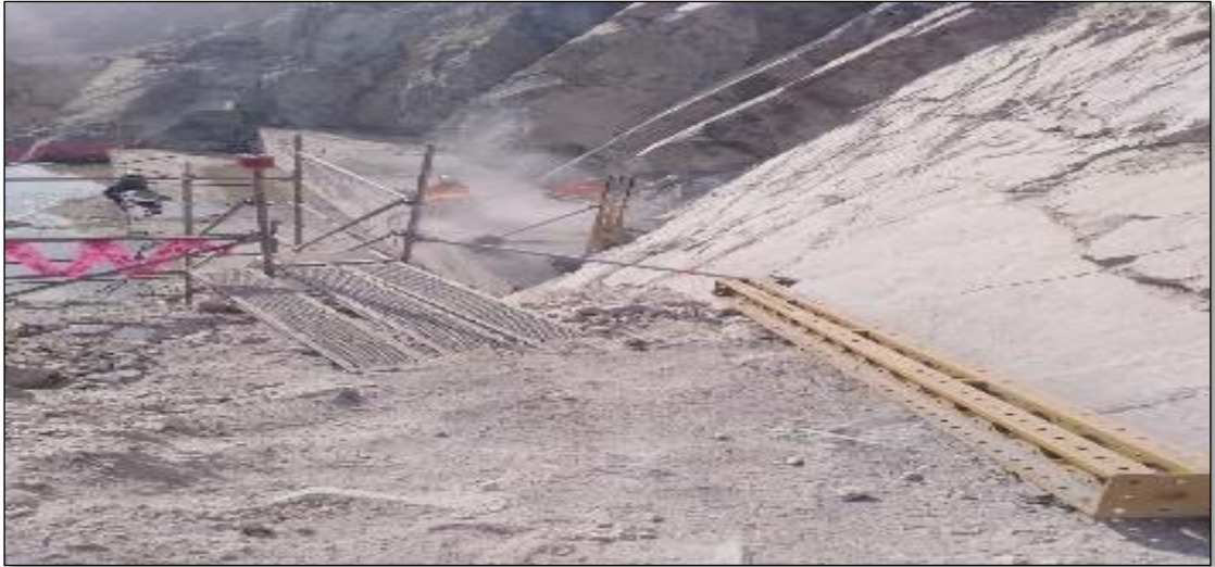
Imagen 11 Solado y perforación para inyecciones de agua cemento pilar 7 FUENTE: Elaboración propia
