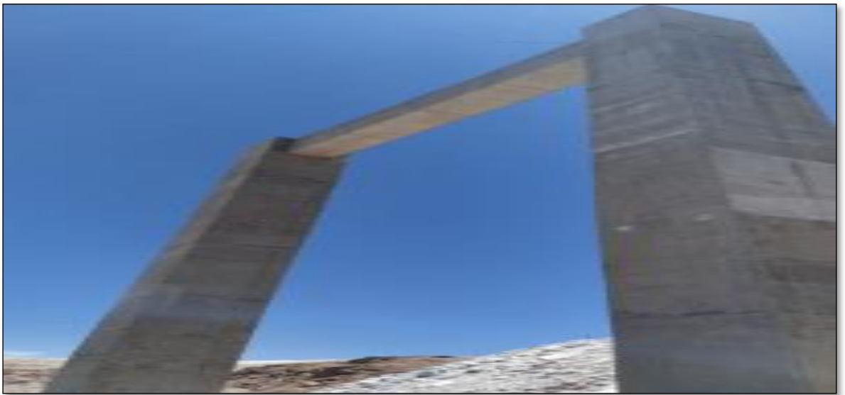
Imagen 8 Viga de pilar 1 y terminación del pilar FUENTE: Elaboración propio
