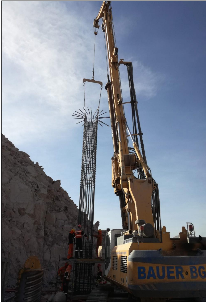
Imagen 2 Colocación de armadura de acero en pilar 9 para pilotes. FUENTE: Elaboración propia
