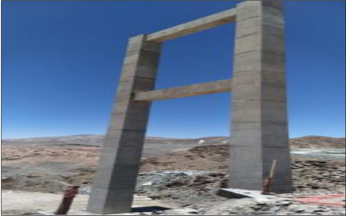
Imagen 17 Culminación del pilar 9 FUENTE: Elaboración propia
