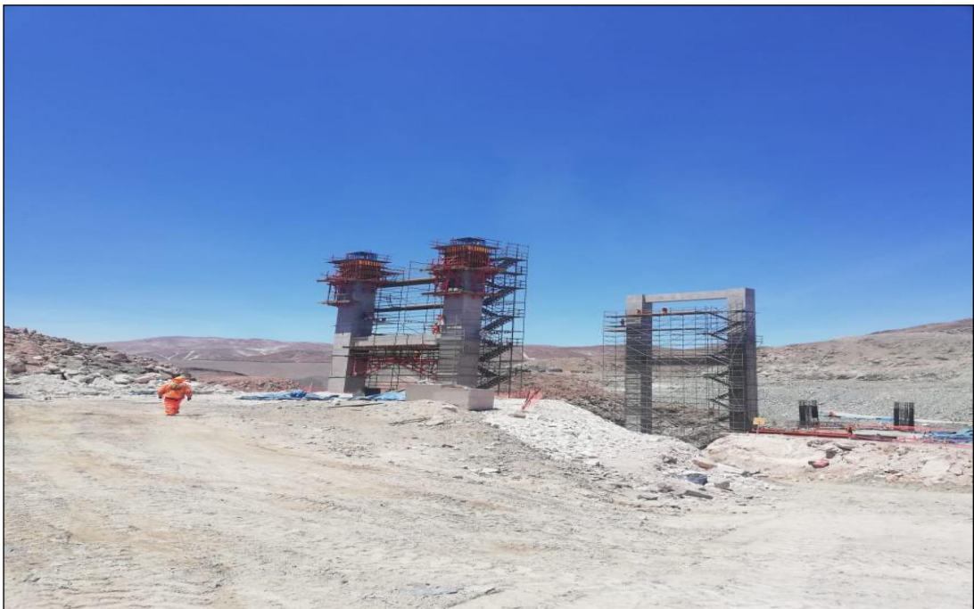
Imagen 16 Encofrado trepante en pilar 9 FUENTE: Elaboración propia
