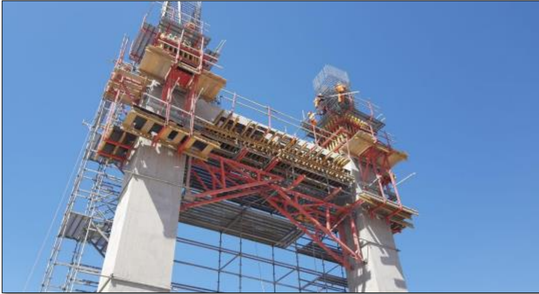
Imagen 13 Proceso constructivo del pilar 7 FUENTE: Elaboración propia
