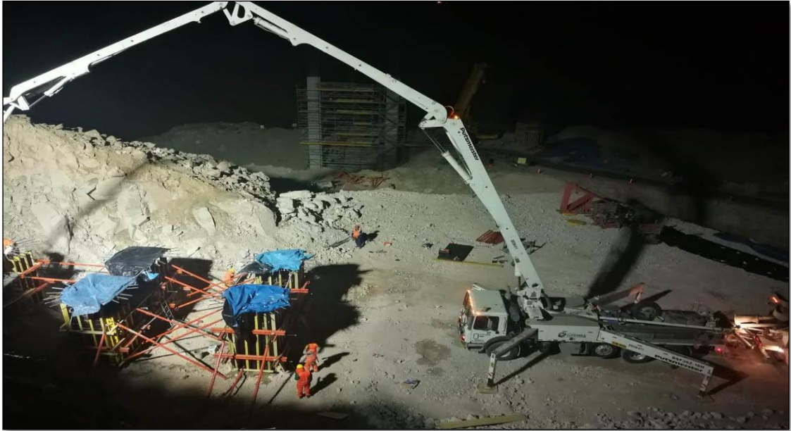
Imagen 3 Concreto en pilotes del pilar 10. FUENTE: Elaboración propia
