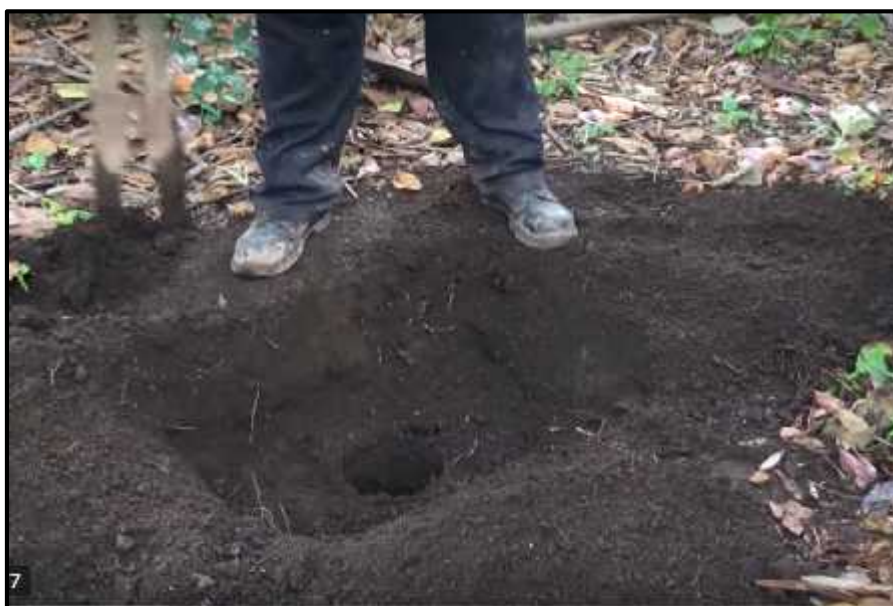
FIGURA A2. Se muestra en la imagen la excavación del terreno de un agujero de 0.30 cm de profundidad y 0.30 cm de diámetro para La prueba de infiltración.
