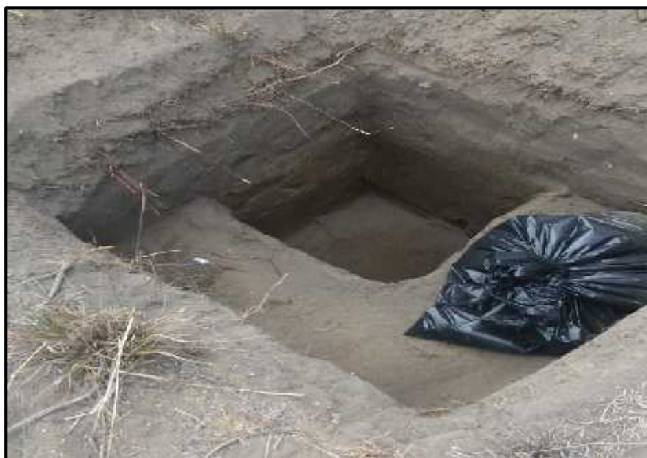
FIGURA A6. Se muestra en la imagen la toma de muestra del tipo de suelo de la calicata N° 3, para el análisis respectivo.
