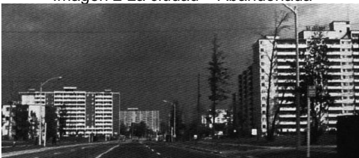
Condominios en Toronto, Canadá Fuente: Libro de la Humanización del espacio urbano
