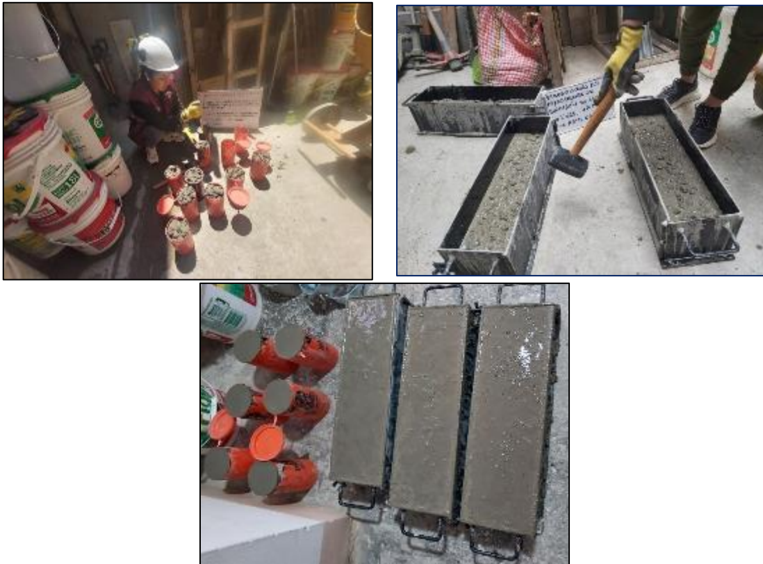
Fotografía 17. Elaboración de probetas y vigas del concreto patrón.
