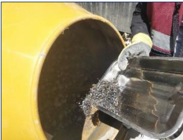
Fotografía 102. Proceso de mezclado del concreto con sustitución parcial del agregado fino por viruta de acero en 10 %.
