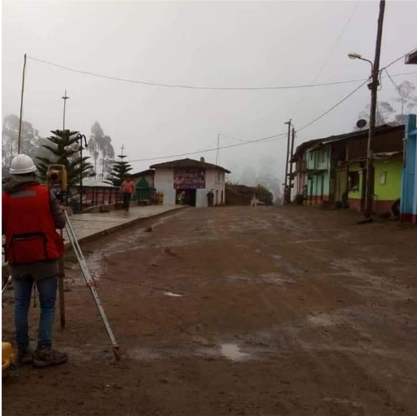
Levantamiento y replanteo de los detalles y control de la pendiente
