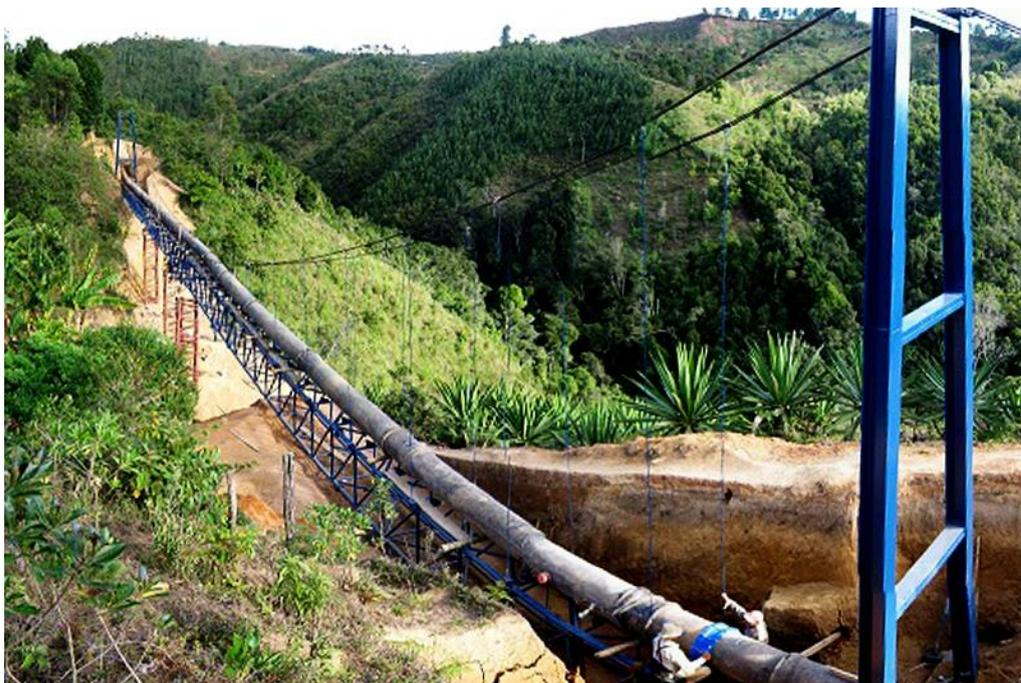
Paso de aire de la línea de conducción
