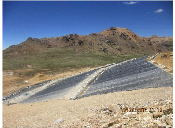
Figura 50 Vista final de la desmontera coberturada con Geomembrana.
