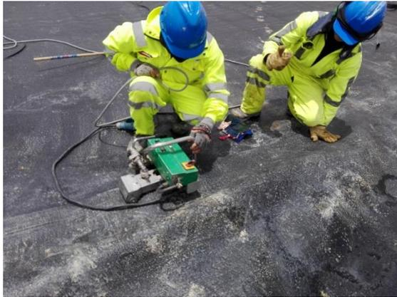
Figura 49 Unión de la Geomembrana con cuña extrusora.
