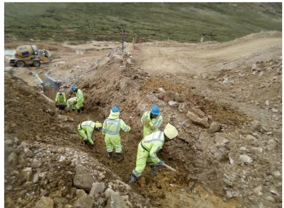
Figura 38 Excavación de zanja para las gradas de disipación.
