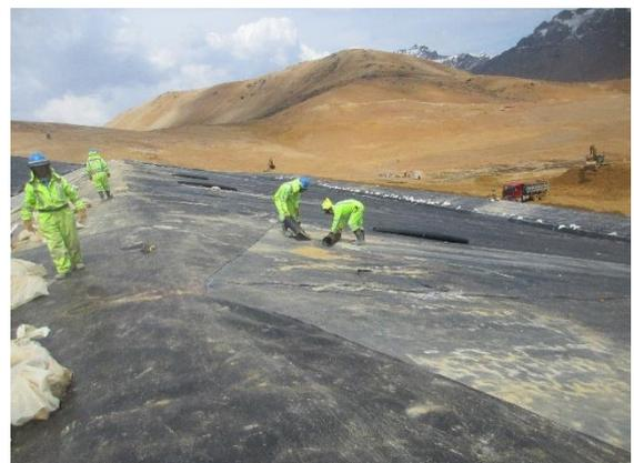
Figura 48 Despliegue de la Geomembrana.
