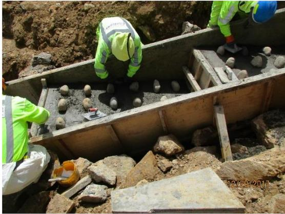
Figura 43 Colocación de piedras disipadoras de energía en las gradas de disipación.
