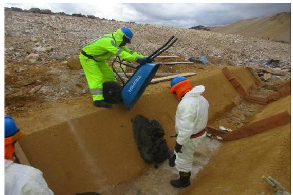
Figura 28 Vaciado del concreto hacia los paños del canal.
