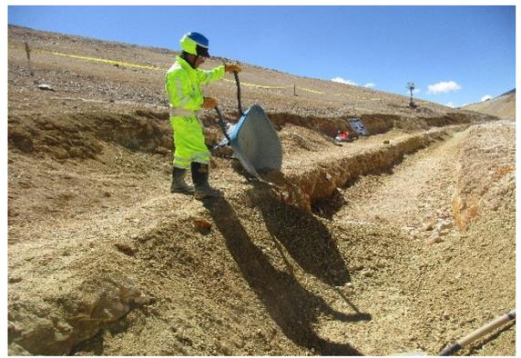
Figura 22 El material de relleno va formando los taludes del canal.
