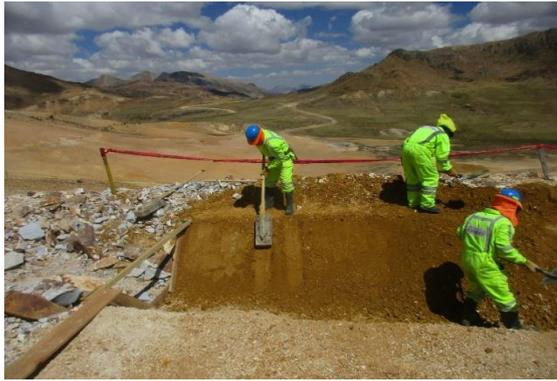
Figura 25 Compactación manual de taludes con material de préstamo.
