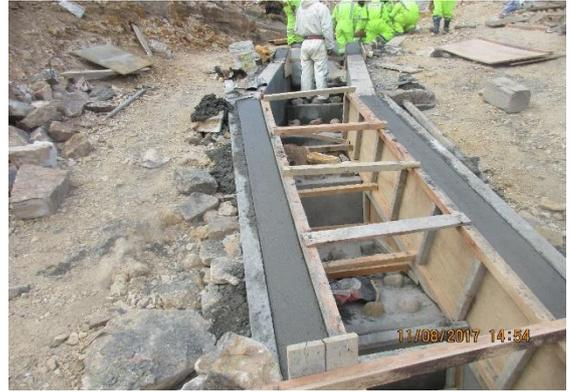
Figura 32 Encofrado y vaciado de paredes laterales de las gradas.
