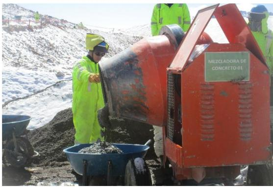
Figura 27 Preparación de concreto con mezcladora y servido a las carretillas.
