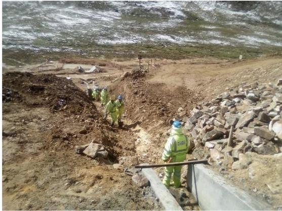
Figura 37 Excavación de zanja para las gradas de disipación.
