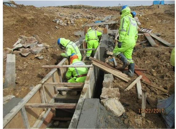
Figura 44 Encofrado de las paredes laterales de las gradas de disipación.
