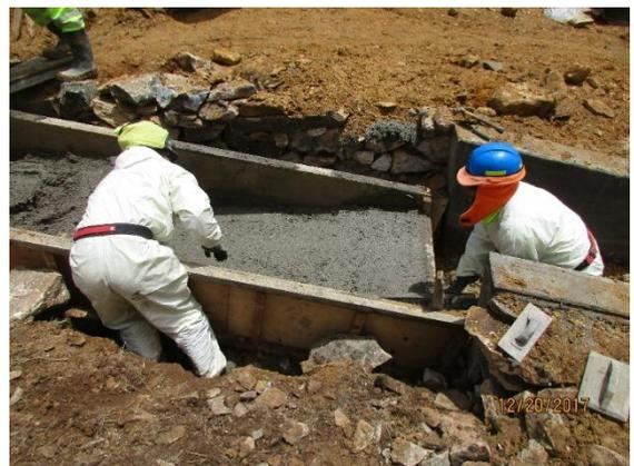
Figura 42 Vaciado de pasos y contrapasos de las gradas.
