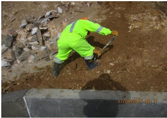
Figura 33 Perfilado de las bermas del canal de coronación.
