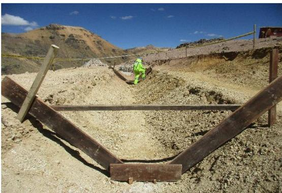
Figura 23 Se plantan los moldes con las medidas del canal especificados.
