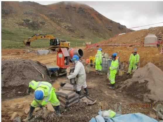
Figura 39 Preparación de concreto con mezcladora.
