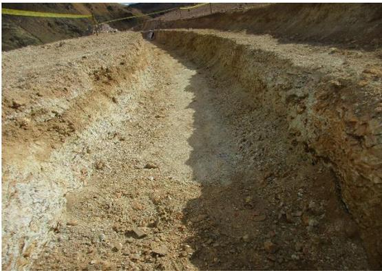
Figura 21 El relleno con material propio se agrupa en los bordes.
