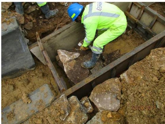
Figura 41 Enrocado de la base de las gradas.
