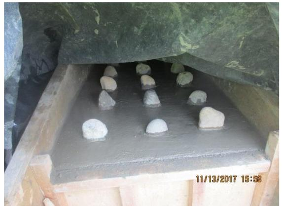
Figura 36 Colocación de piedras disipadoras en las gradas (8").
