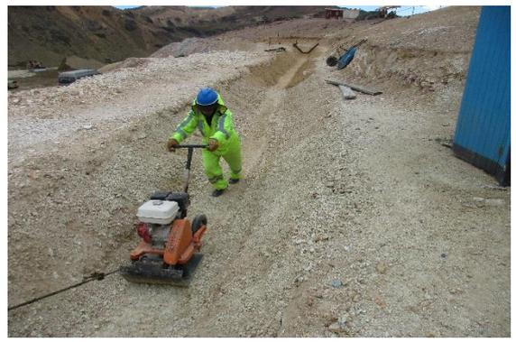
Figura 24 El piso es compactado con equipo, para una mejor conformación.
