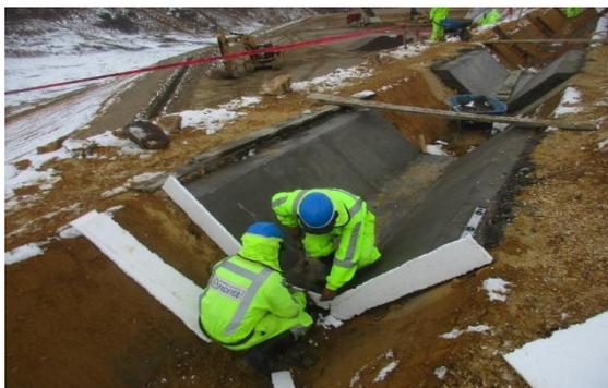
Figura 29 Colocación de tecknoport para las juntas de dilatación (temporal).
