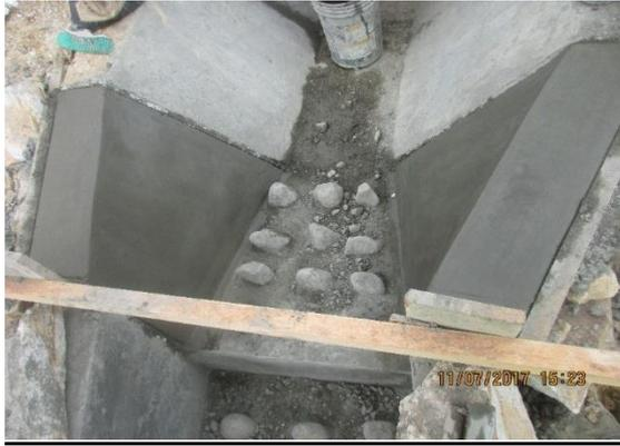
Figura 31 Vaciado y acabado de transición 1 (cambio a gradas).
