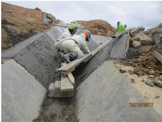
Figura 45 Vaciado y acabado del empalme canal 02 y de coronación.
