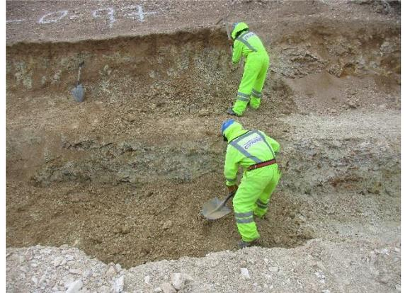
Figura 20 Relleno del canal con material propio.
