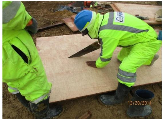
Figura 40 Preparación de encofrado con paneles.
