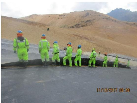
Figura 47 Despliegue de la Geomembrana.
