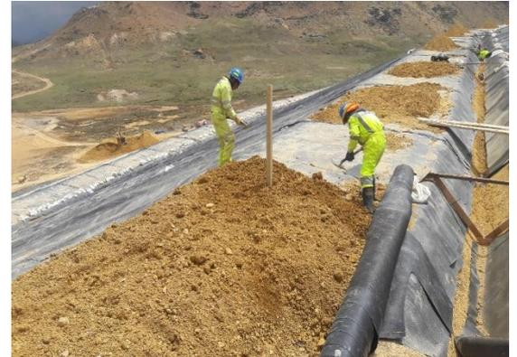
Figura 34 Colocación de 0.40 m de morrena en la Geomembrana.
