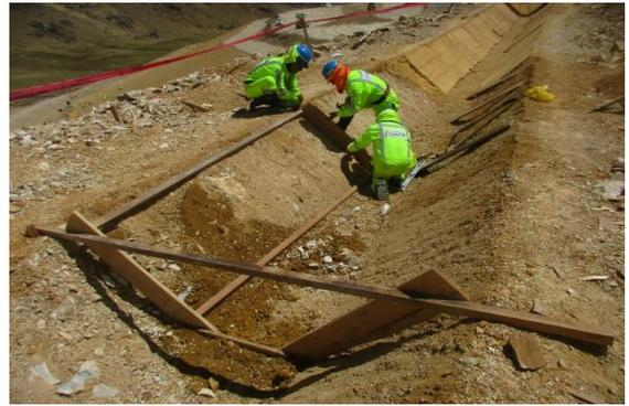
Figura 26 Colocación de cerchas a cada 3 metros (encofrado de paños).
