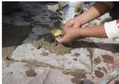
Preparación del enconfrado
