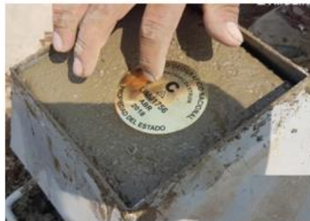
Instalación de la placa del punto geodésico
