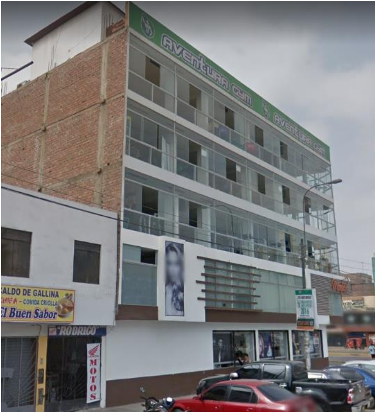
Vista del edificio aporricado con muros confinados en los lados perimetrales, ubicado en la intersección de la Av. Naranjal con Av. Las palmeras – Los Olivos
