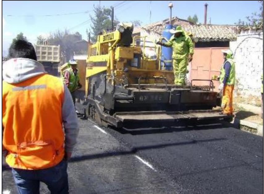
Figura 20. Colocación de la carpeta asfáltica con la máquina pavimentadora.
