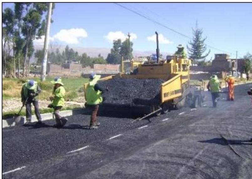
Figura 21. Esparcido de la mezcla asfáltica sobre el geotextil.
