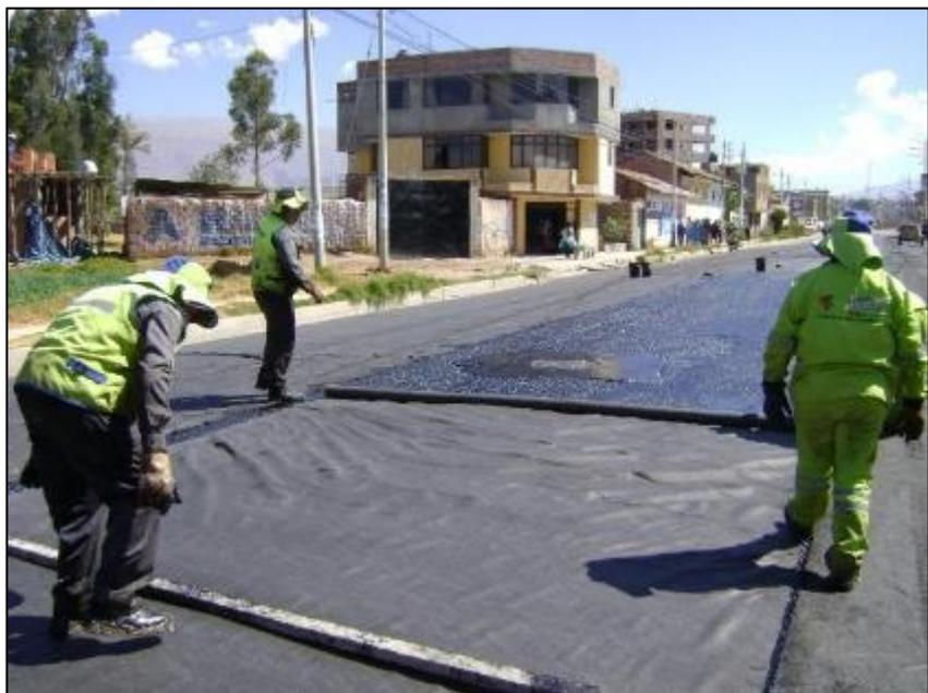
Figura 19. Traslape del geotextil tipo REPAV 450.
