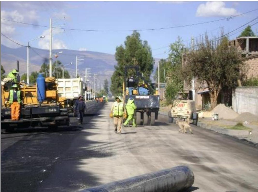
Fotografía 24. Compactación de la carpeta de rodadura.
