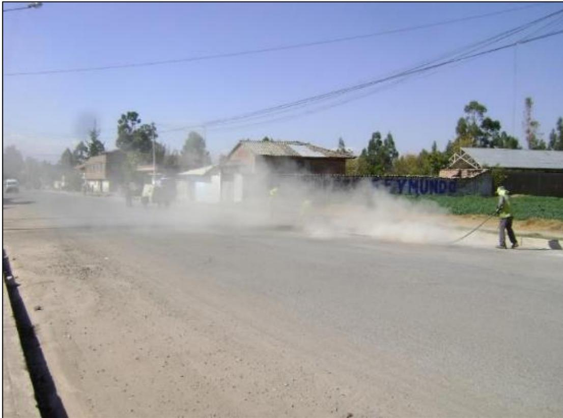
Fotografía 1. Limpieza general de la superficie de rodadura.
