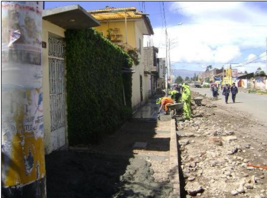
Fotografía 22. Vaciado de concreto y nivelado de veredas.
