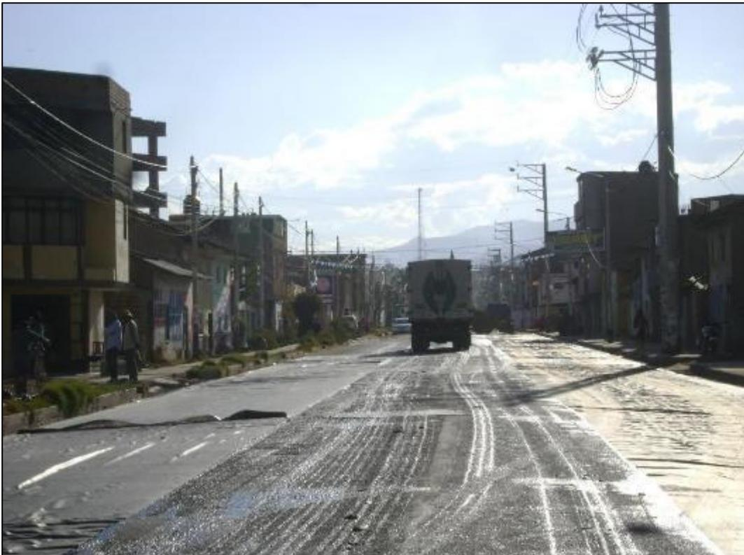
Fotografía 26. Tendido del geotextil tipo REPAV 450.
