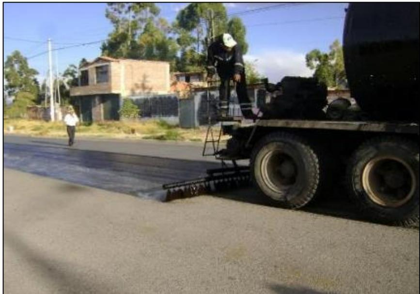
Figura 15. Riego de liga con emulsión asfáltica catiónica CRS – 2.
