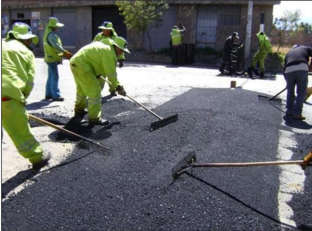
Fotografía 33. Colocación de gibas del margen izquierdo.
