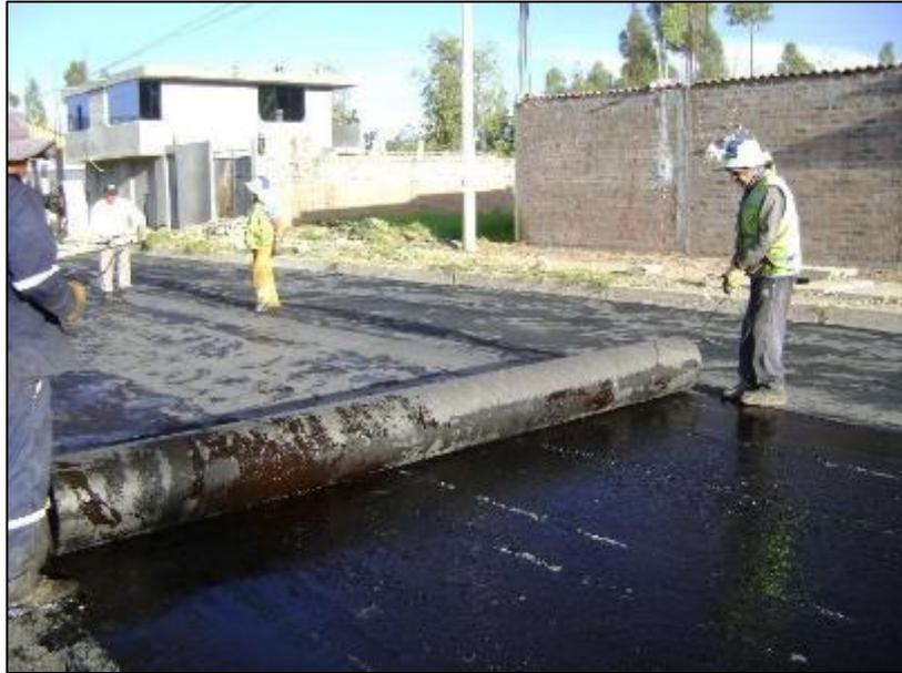
Figura 18. Tendido de geotextil procurando el alineamiento correspondiente.
