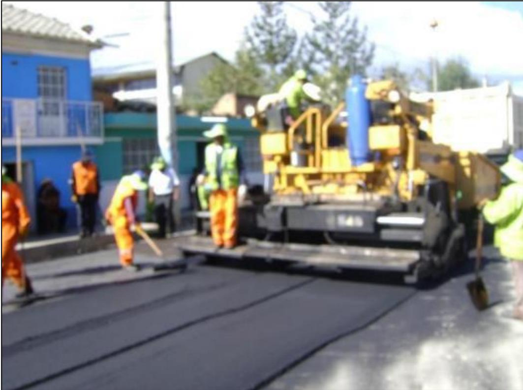
Fotografía 25. Colocación de la mezcla asfáltica.
