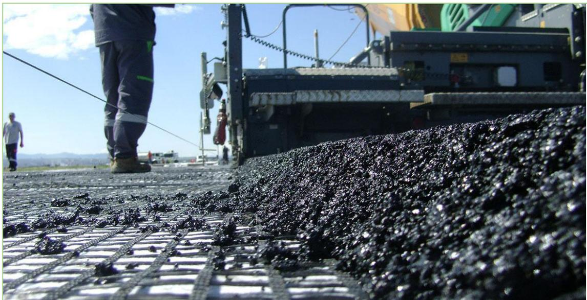
Figura 5. Utilización de geosintéticos en carpeta asfáltica.
