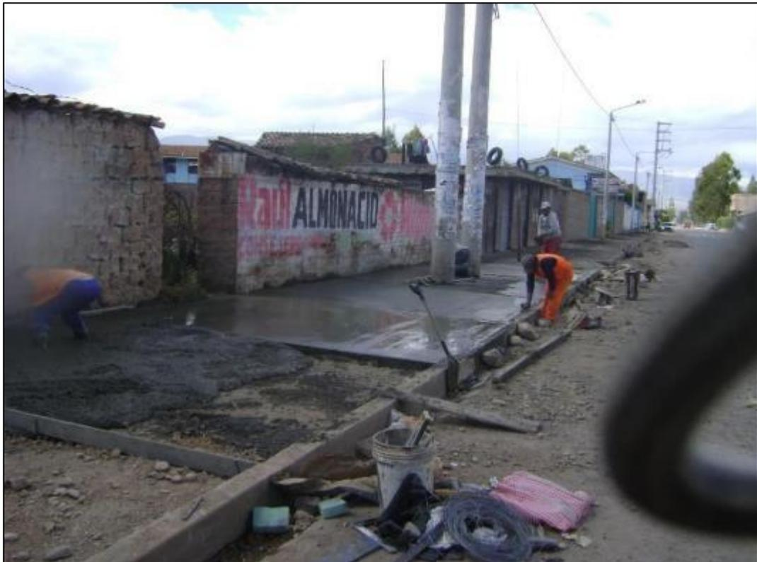
Fotografía 14. Vaciado del concreto en el margen izquierdo.
