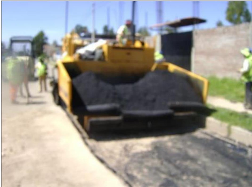
Fotografía 3. Colocación del cemento asfáltico en los baches.
