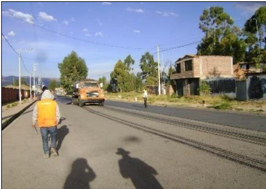
Figura 13. Riego de liga con el camión distribuidor.
