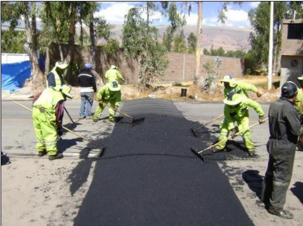
Fotografía 32. Colocación de gibas de 2 m de ancho.
