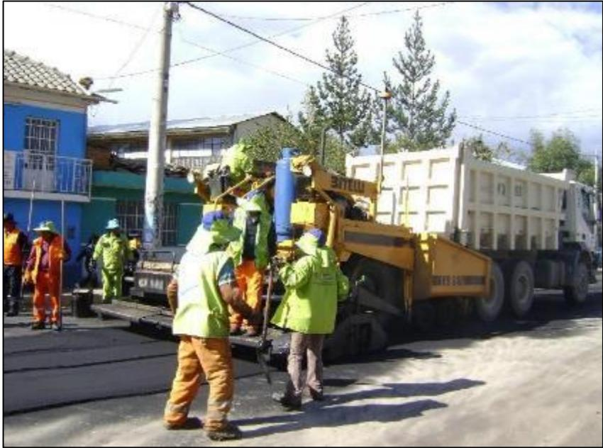
Figura 22. Perfilado y nivelado de la carpeta asfáltica.
