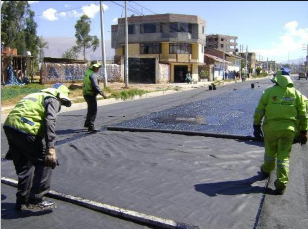
Fotografía 27. Tendido del geotextil en las progresivas.
