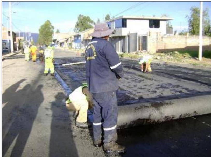
Figura 17. Tendido de geotextil tipo REPAV 450.
