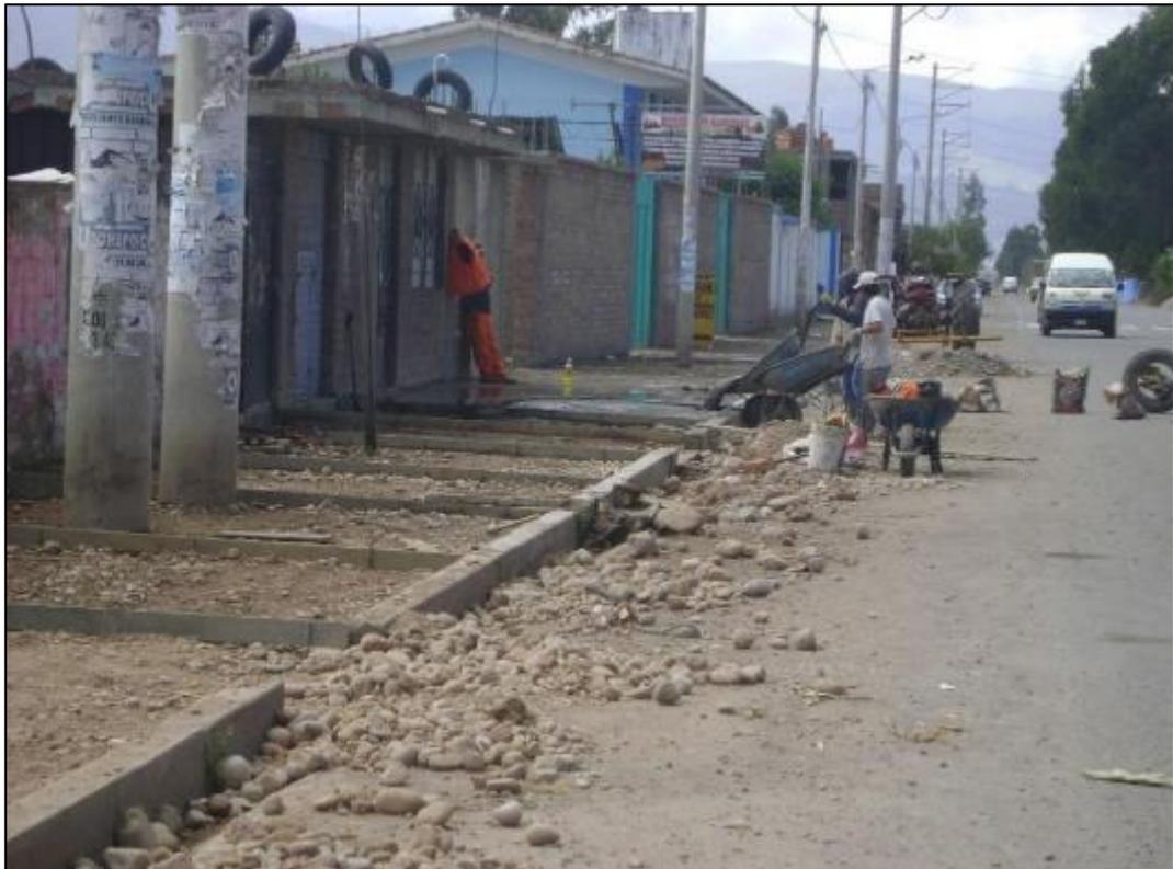
Fotografía 12. Vaciado de concreto en veredas.
