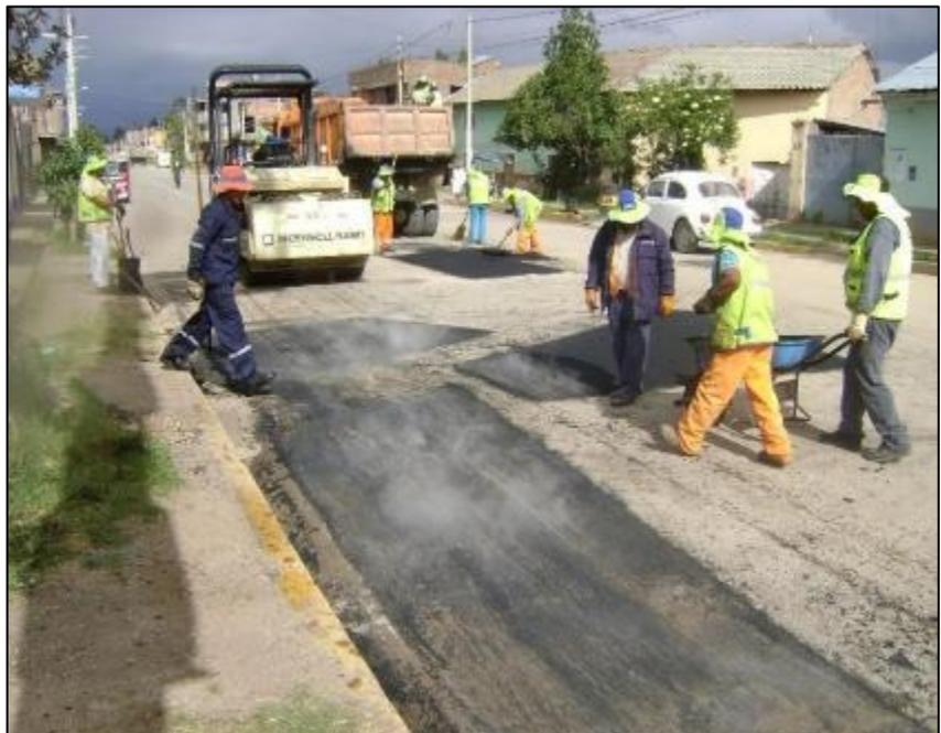
Figura 12. Preparación de la carpeta existente – parchado de baches.
