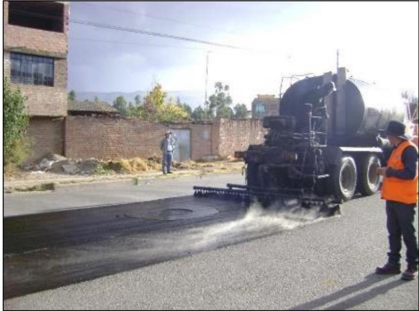
Figura 14. Riego de liga en la carpeta existente.
