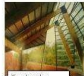
Vigas de madera
