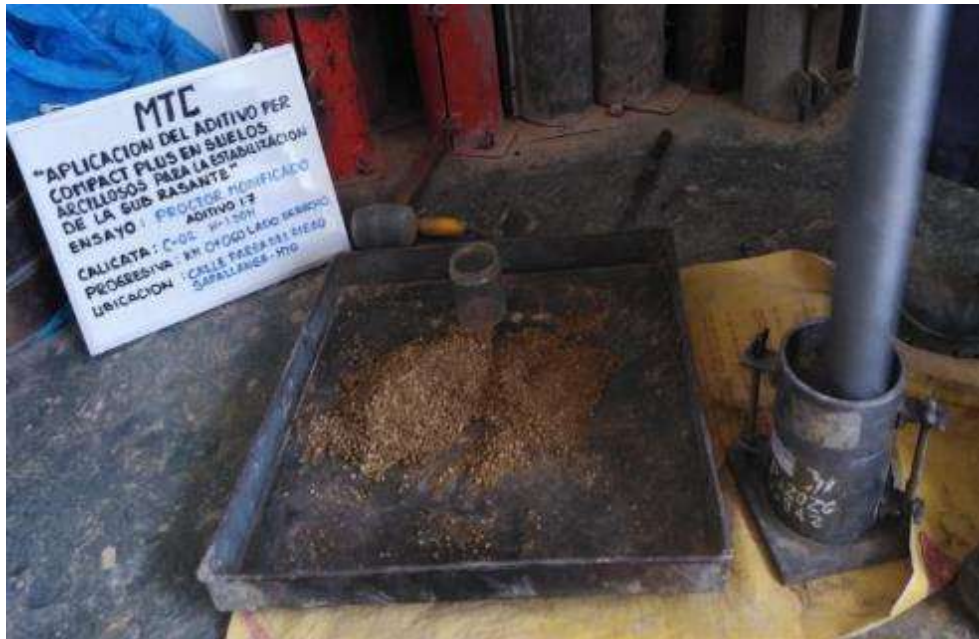
Fuente propia: Colocación de la mezcla en el molde por capas.
