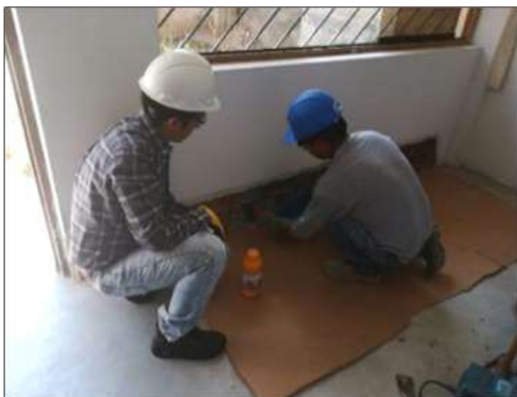
Ilustración 34. Aplicación del aditivo ImperMur.
