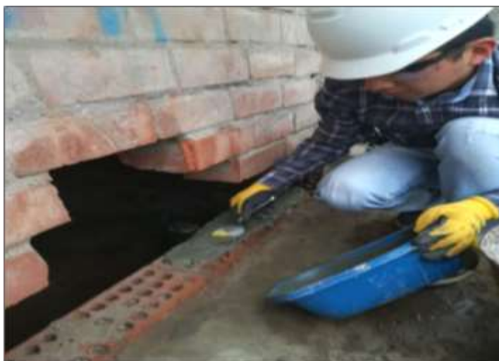
Ilustración 41. Colocación de la pasta de cemento.
