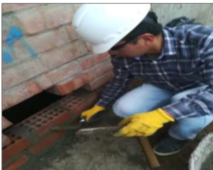
Ilustración 42. Colocación de ladrillos de 18 huecos KK.
