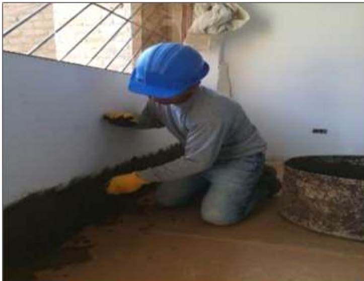
Ilustración 35. Colocación de nuevo mortero.
