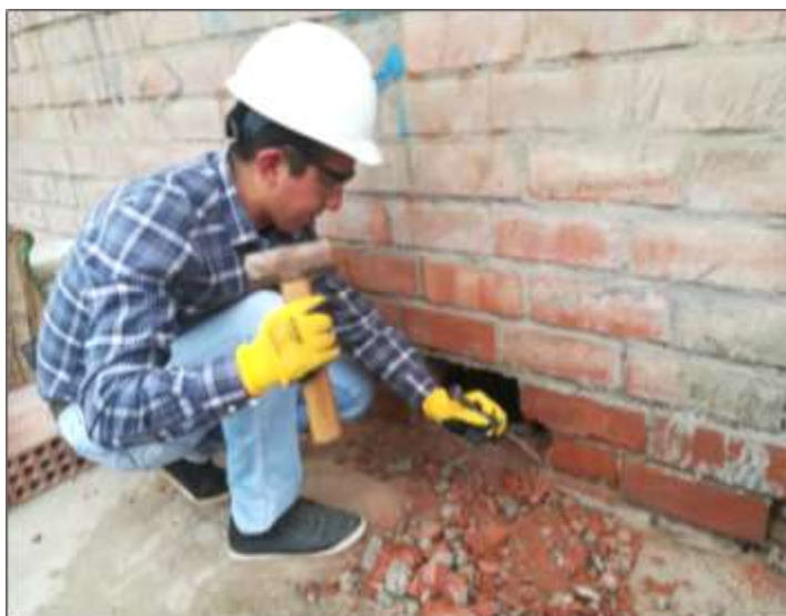
Ilustración 39. Retiro de ladrillos afectados.
