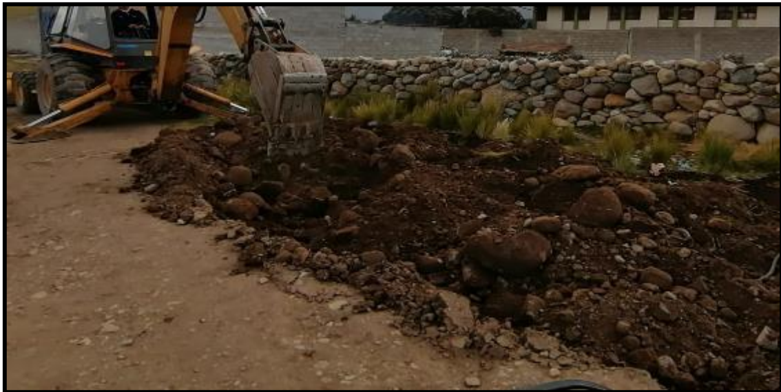
Fotografía N°1: Movimiento de tierra del tramo de prueba.
