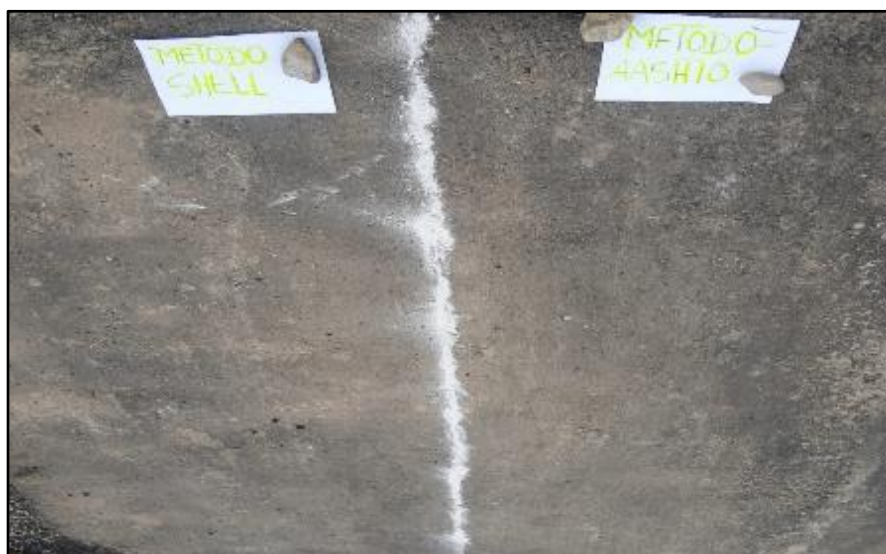
Fotografía 6. Carpeta asfáltica elaborada con diferentes métodos
