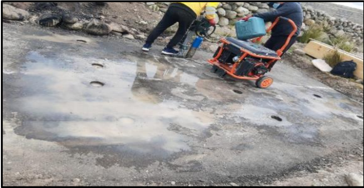
Fotografía N°5: extracción de núcleos – Método AASHTO.
