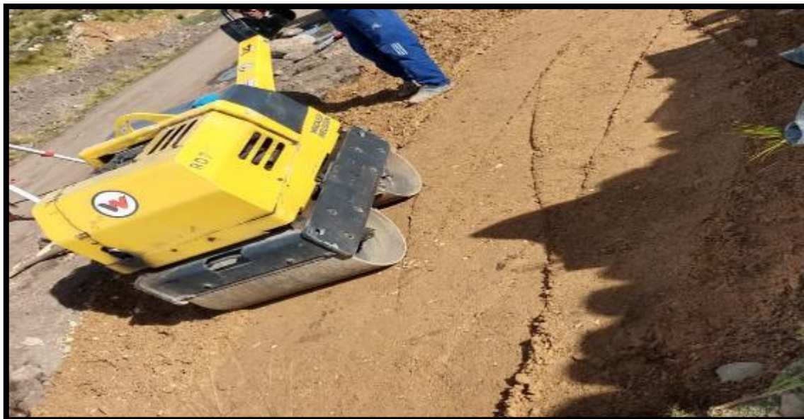
Fotografía N°6: Finalizando compactación de la base.
