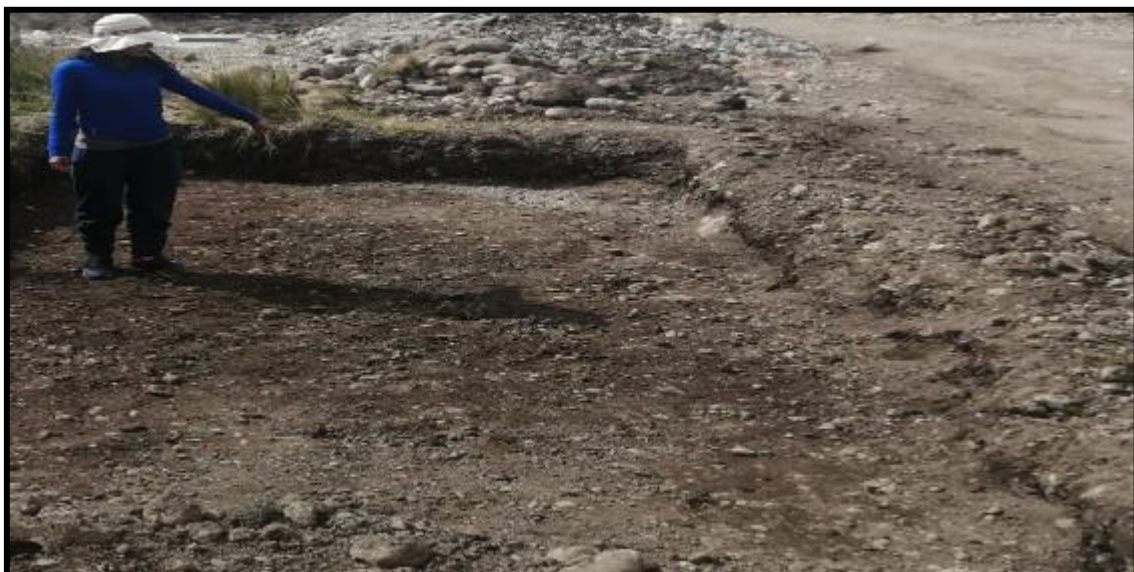
Fotografía N°2: Perfilado después de la eliminación de material del tramo de prueba.
