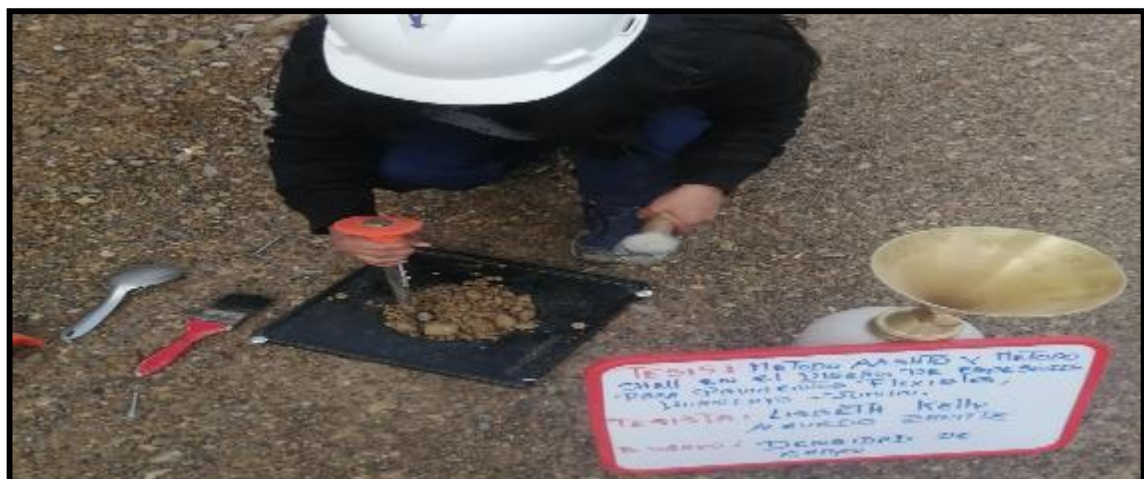
Fotografía N°2: Con ayuda de un cincel y una comba removemos el material que está dentro de la placa metálica hueca.
