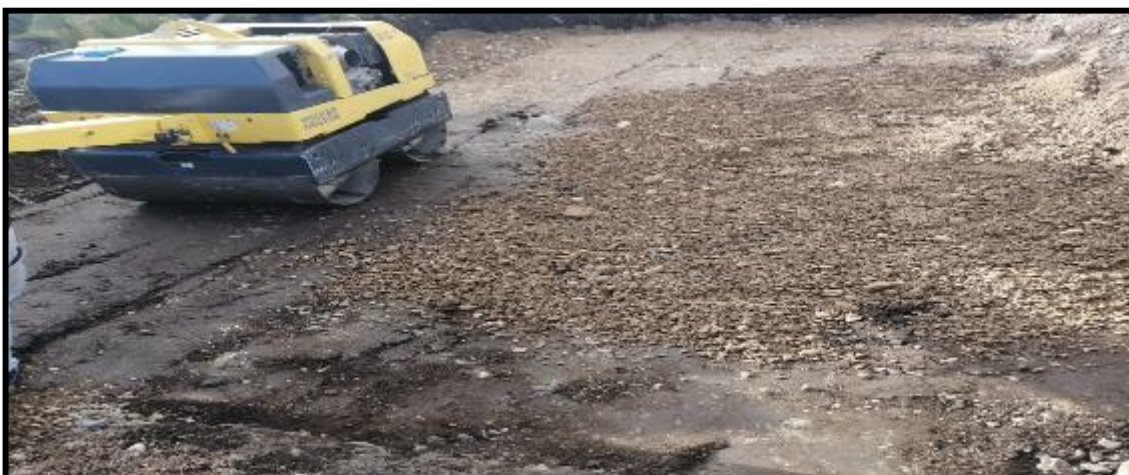
Fotografía N°5: Finalizando compactación de la base.
