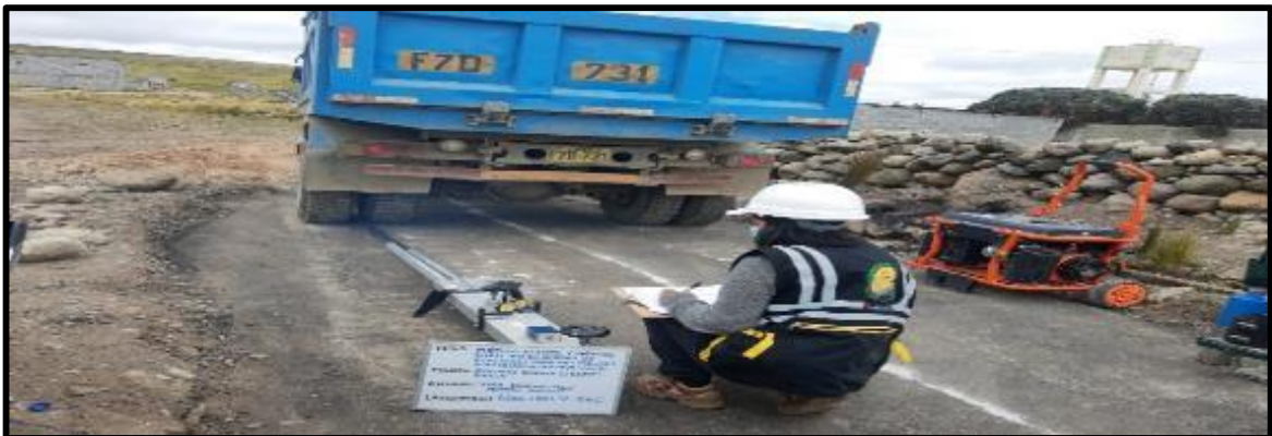
Fotografía N°2: Lectura de la viga Benkelman después de arrancado el volquete de 8 toneladas – Método AASHTO.
