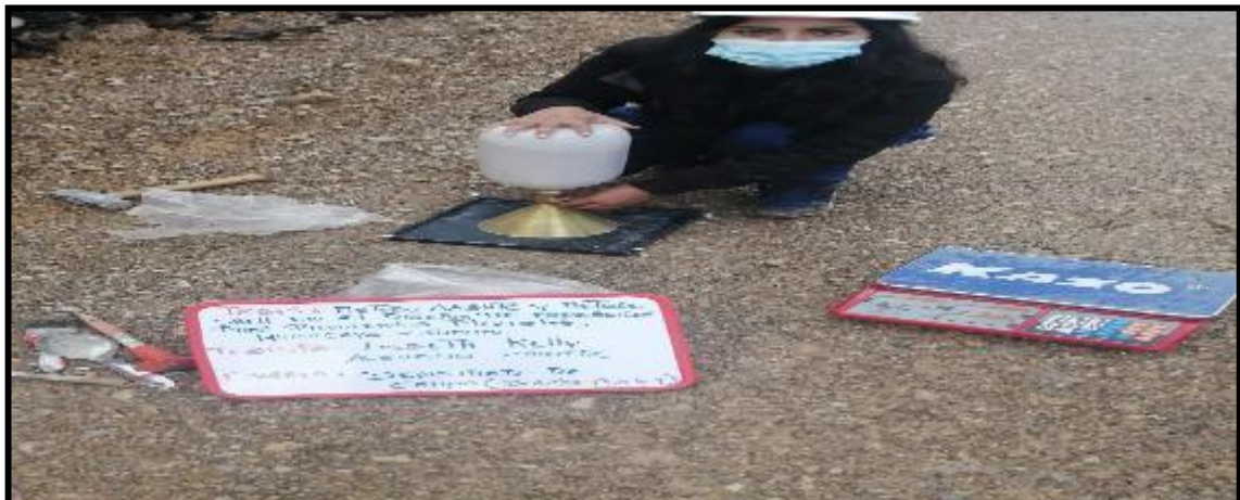
Fotografía N°6: Vaciamos el cono de arena al hoyo que quedo hasta rellenar todo el espacio vacío del hueco.
