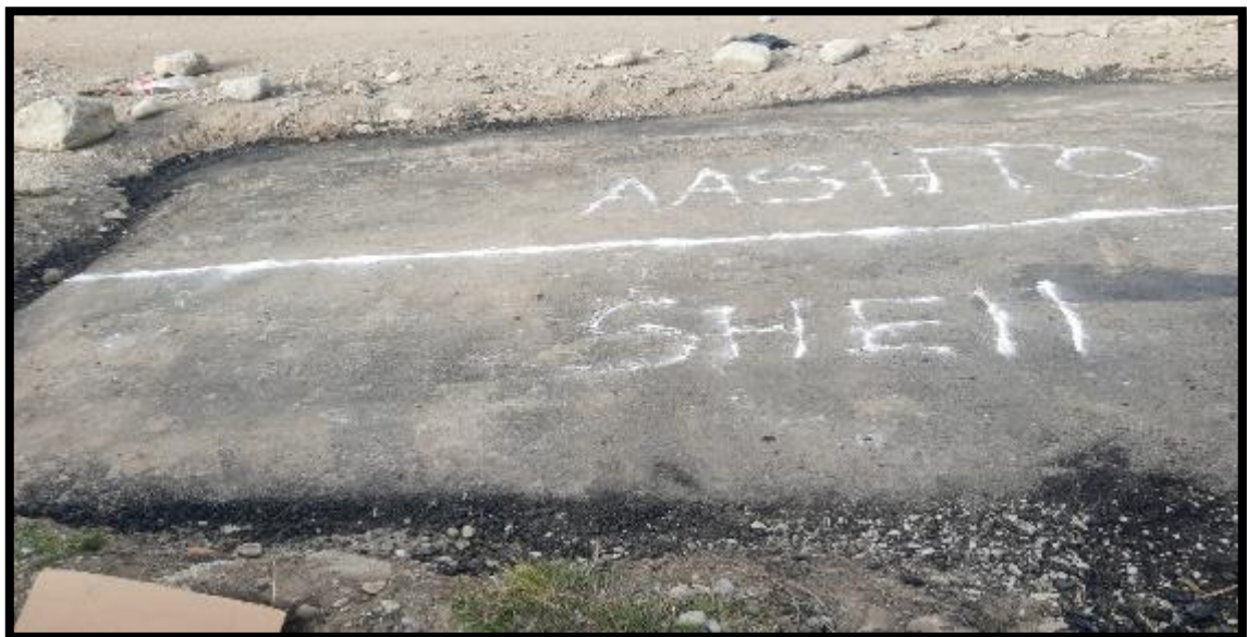
Fotografía N°7: Carpeta asfáltica terminada para el METODO AASHTO Y METODO SHELL.
