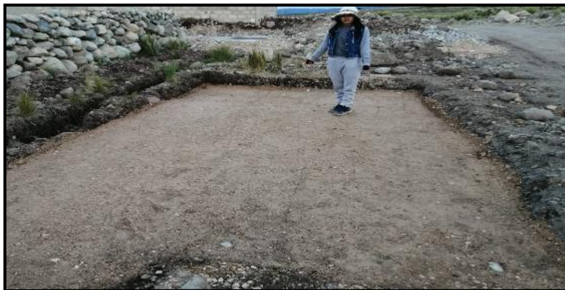
Fotografía N°7: Superficie de la base granular compactada para ambos métodos – METODO AASHTO Y METODO SHELL.
