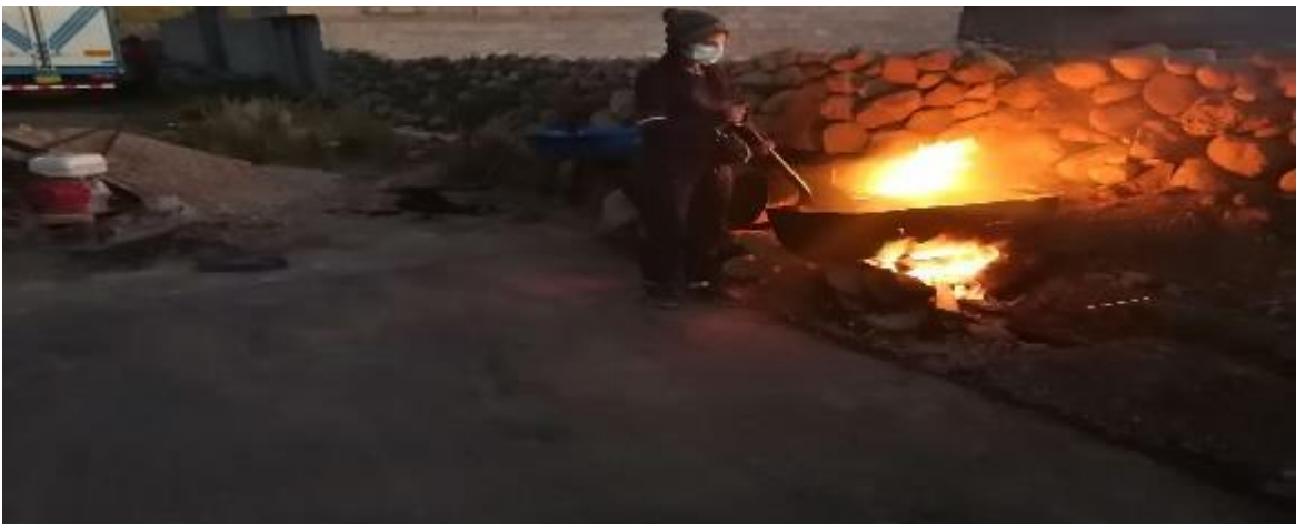
Fotografía N°2: Mezcla en caliente de los agregados con el material bituminoso obtenido del asfalto o petróleo.
