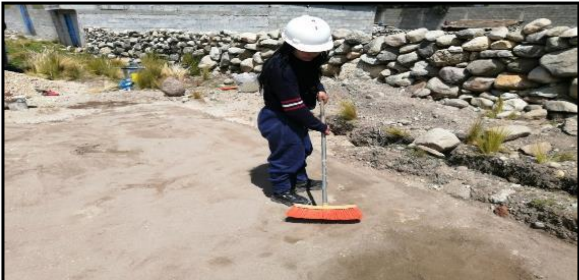
Fotografía N°1: Limpieza del tramo de prueba para realizar la imprimación.
