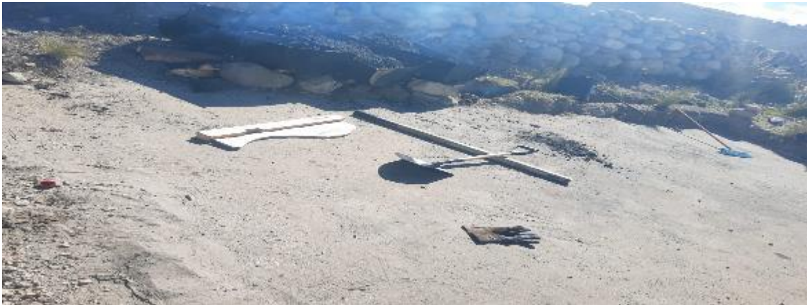
Fotografía N°1: Preparación para la colocación de la carpeta asfáltica.
