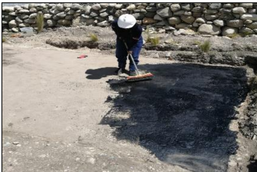
Fotografía 5. Imprimación asfáltica con emulsión
