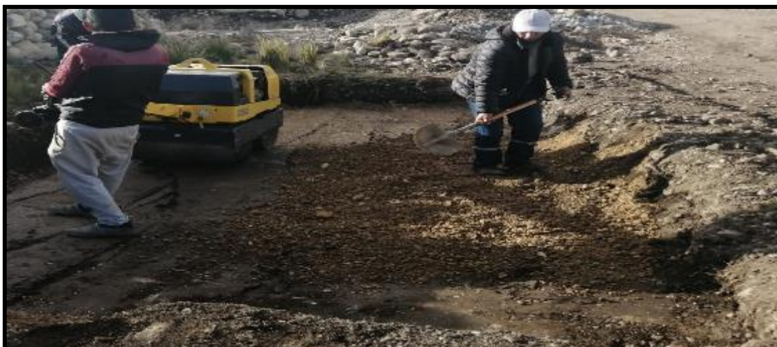
Fotografía N°4: Compactación de la base con material de préstamo en 3 capas.
