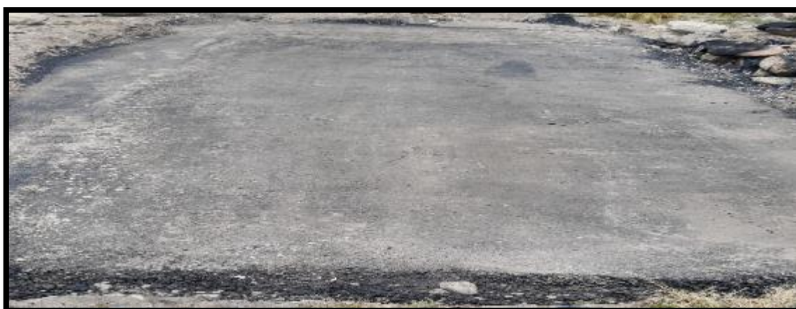
Fotografía N°5: Culminación del colocado de la carpeta para ambos métodos.
