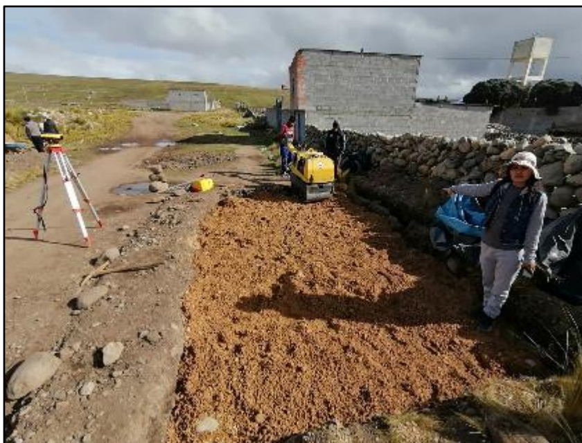
Fotografía 1. Colocación de la base granular
