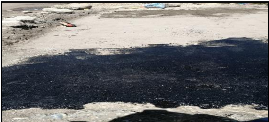
Fotografía N°2: Colocación de la imprimación asfáltica con emulsión.
