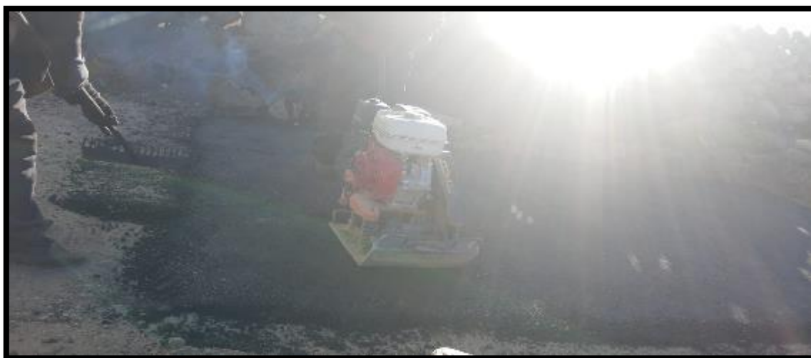
Fotografía N°3: Colocación y compactado de la carpeta asfáltica para el método AASHTO.
