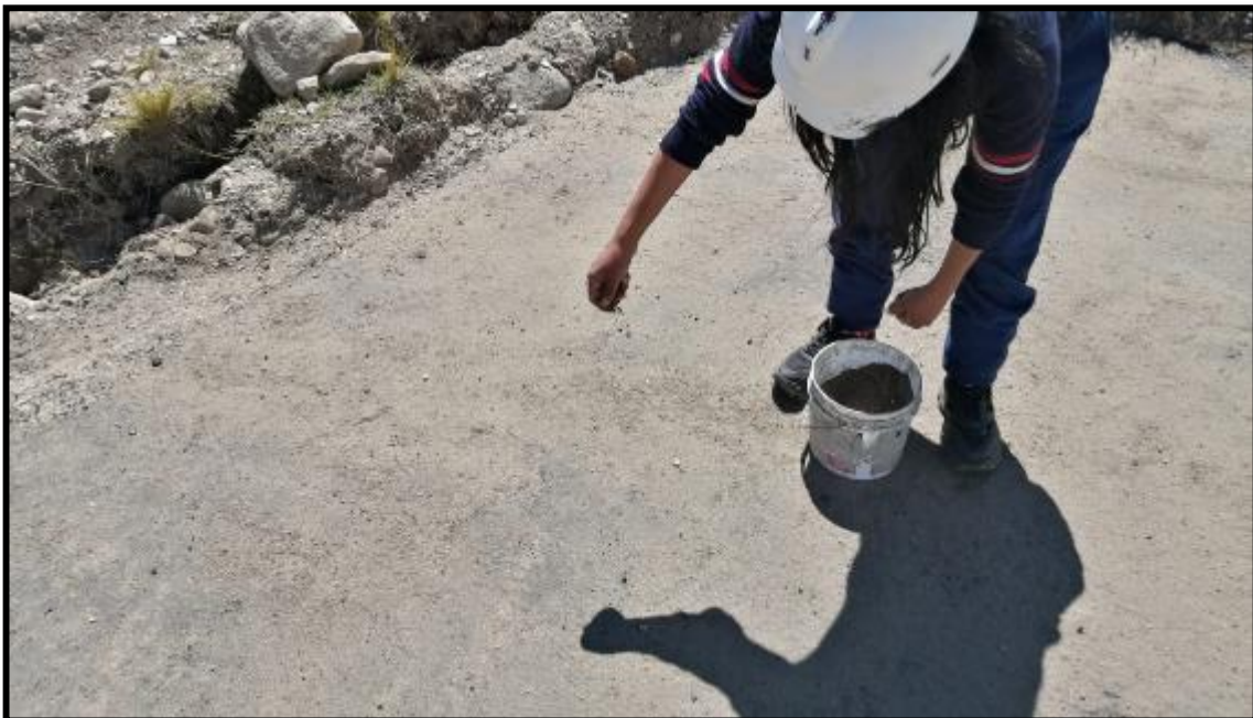
Fotografía N°4: Después de emplear la imprimación se dispersó arena para el secado rápido.
