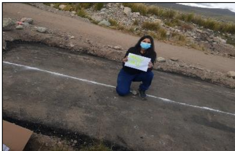
Fotografía 8. Tramo de prueba según la metodología AASHTO
