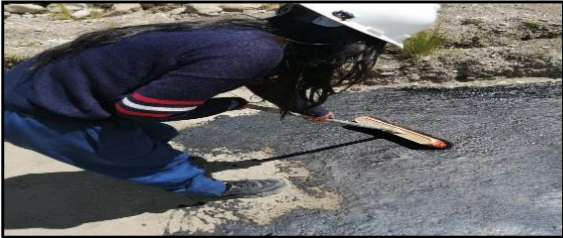
Fotografía N°3: Colocación de la imprimación asfáltica con emulsión.
