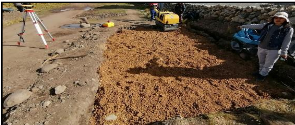
Fotografía N°3: Colocación de la base granular con material de préstamo.
