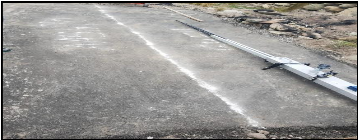
Fotografía N°1: Tramo e instalación de equipo (Viga Benkelman).
