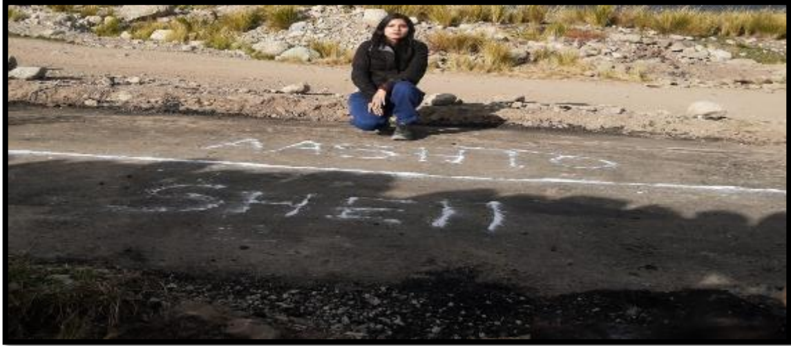
Fotografía N°6: Carpeta asfáltica terminada para el METODO AASHTO Y METODO SHELL.
