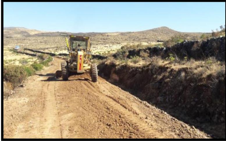
Foto 27 Perfilado y Compactado de Subrasante en zonas de corte (m<sup>2</sup>)
