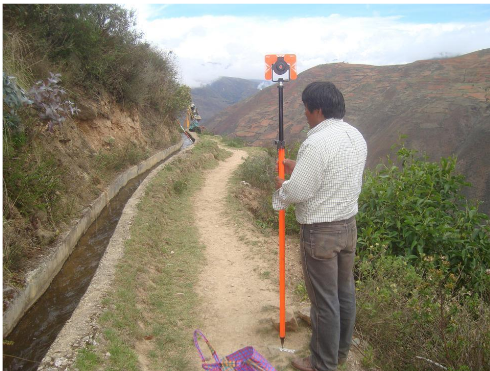
Figura 6 Levantamiento topográfico de los taludes de corte Fuente: Elaboración propia.
