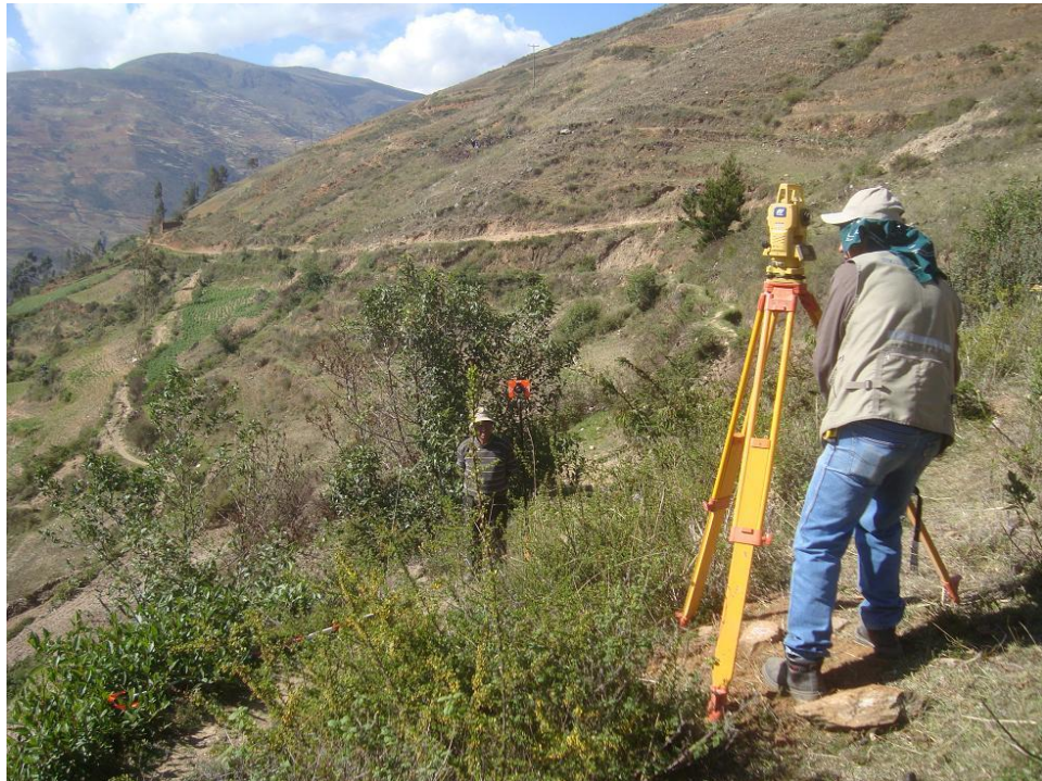
Figura 4 Levantamiento topográfico de la corona de los taludes de corte Fuente: Elaboración propia.
