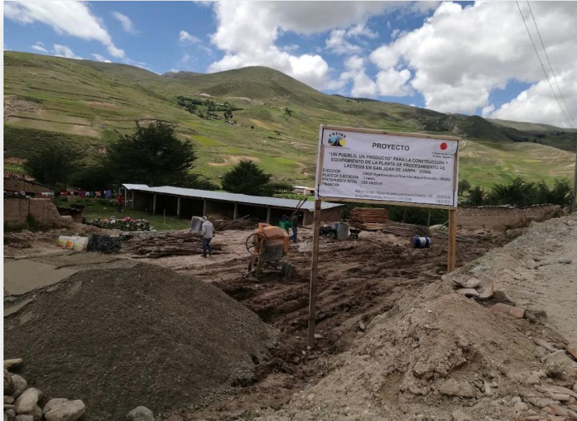
Construcción de Planta de Lácteos en San Juan de Jarpa
