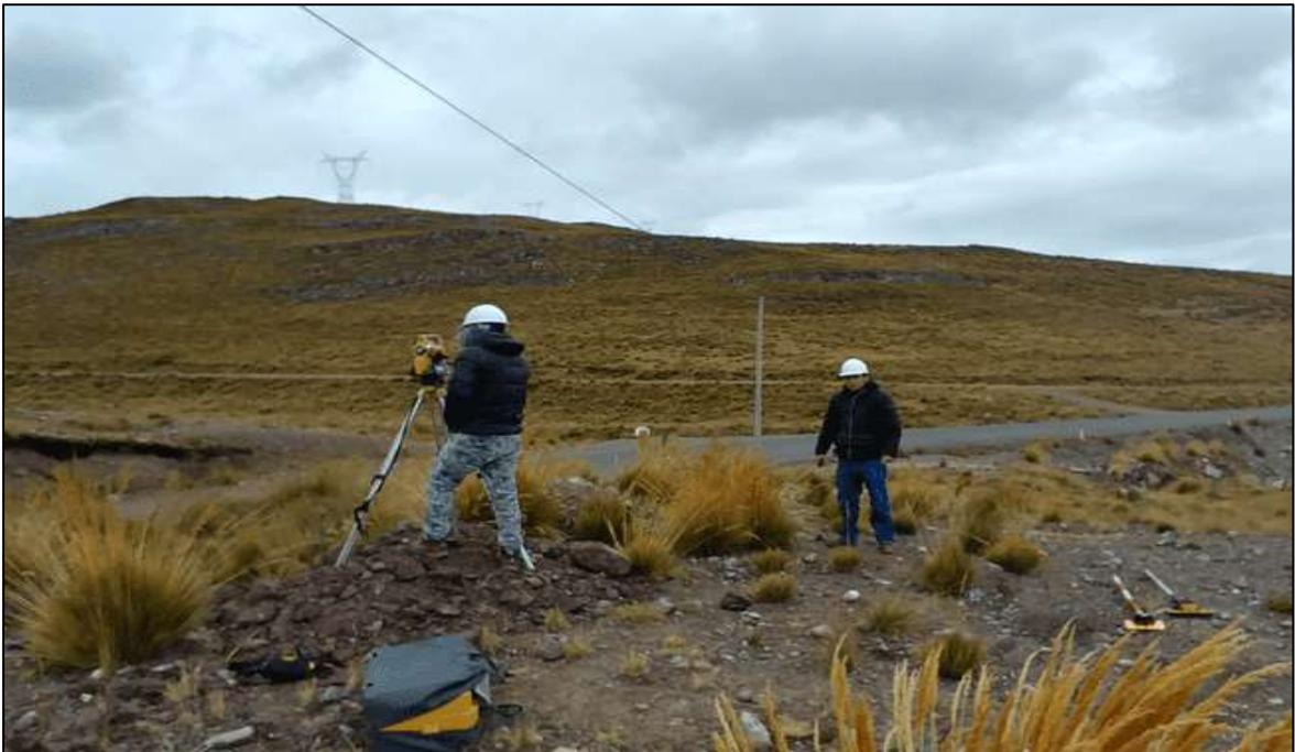
**Figura N°04:** Se observa el levantamiento topográfico y toma de datos del tramo Km 9+00.00 – 10+000 Carretera Carhuamayo – Paucartambo.
