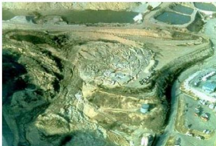
FIGURA 6. Rotura de la Presa Tapo Canyon causada por el Terremoto de Northridge en 1994. (FOTO: Northridge Collection, EERC, University of California, Berkeley)
