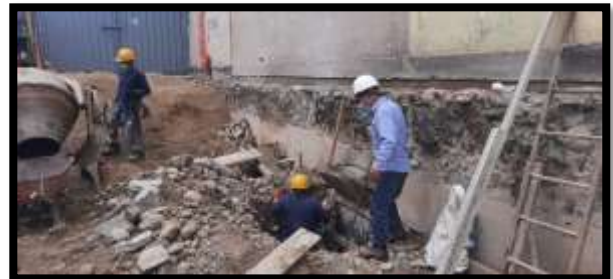
Fotografía 20: Desencofrado de calzada
