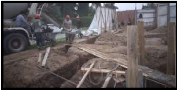
Fotografía 27: Vaciado de cimiento de cimiento
