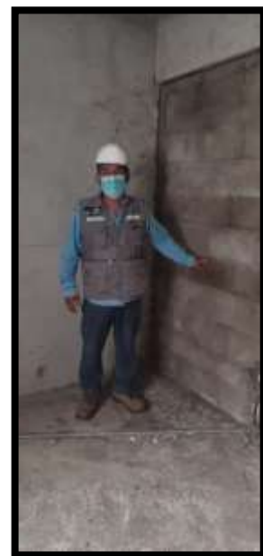
Fotografía 63: Tarrajeo en dormitorio
