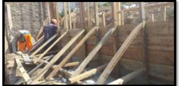
Fotografía 28: Encofrado de sobrecimiento
