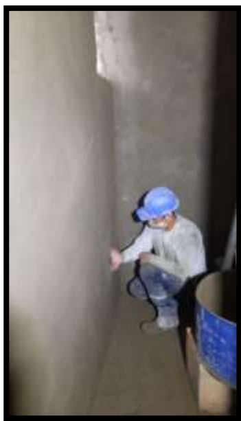
Fotografía 61: Tarrajeo en baño
