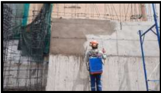
Fotografía 34: Curado de placas
