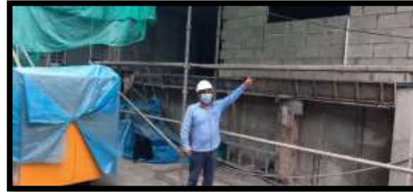
Fotografía 6: Revisando los andamios
