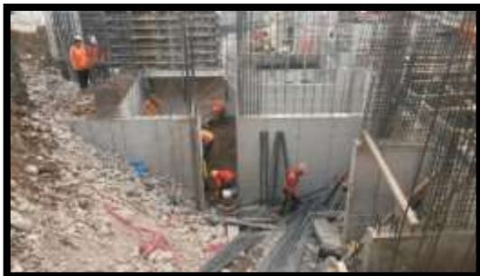
Fotografía 36: Armado de placas
