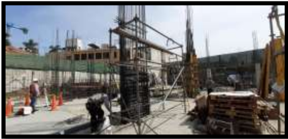
Fotografía 32: Armado de placas
