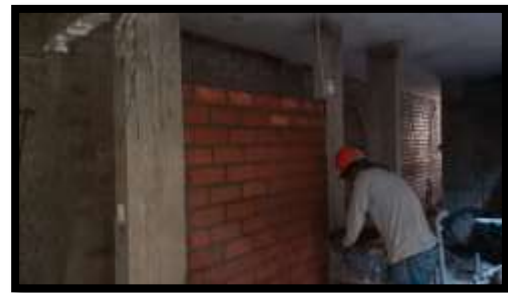
Fotografía 51: Asentado de muro no portante de sogá
