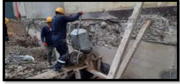
Fotografía 18: Vaciado de calzada
