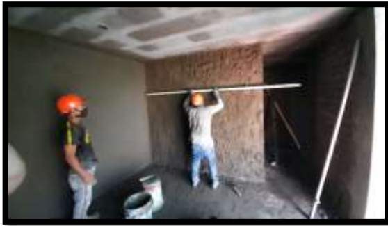
Fotografía 59: Tarrajeo de muros
