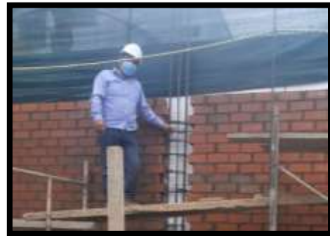
Fotografía 35: Confinamiento de estribos en columnas
