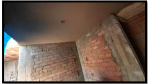
Fotografía 55: Tarrajeo de cielo raso
