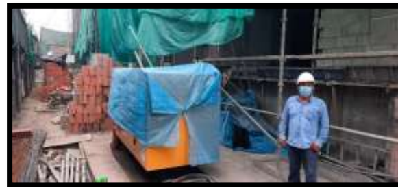
Fotografía 8: Inspeccionando los andamios
