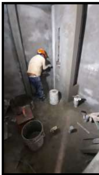
Fotografía 62: Tarrajeo en baño
