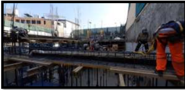
Fotografía 40: Encofrado de vigas
