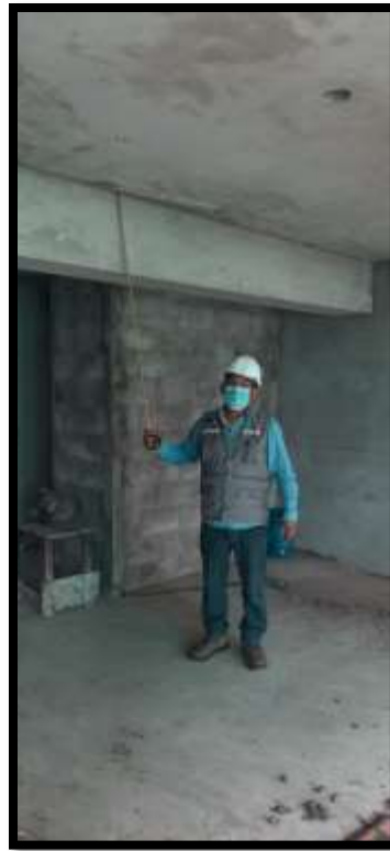
Fotografía 57: Tarrajeo de cielo raso
