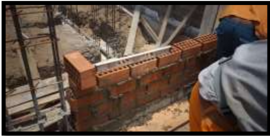
Fotografía 50: Asentado de muro en divisiones de sogá
