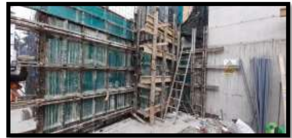
Fotografía 33: Encofrado de placas
