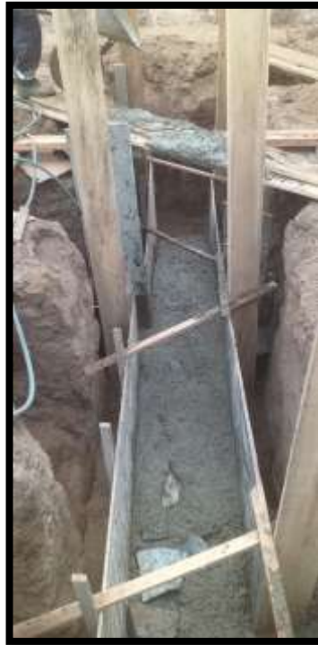
Fotografía 29: Vaciado de cimiento
