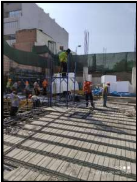
Fotografía 42: Acero de temperatura en losa aligerada
