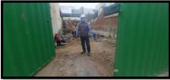
Fotografía 1: Ingreso a obra
