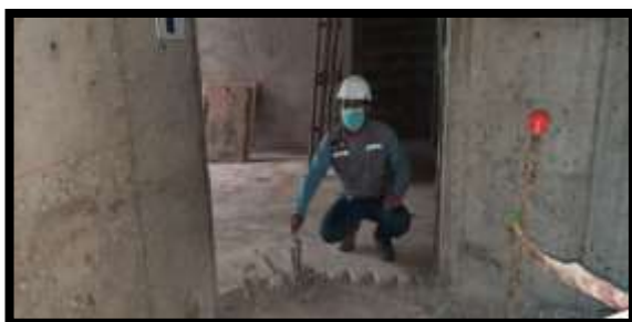
Fotografía 64: Inspección de contrapiso
