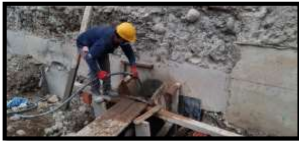
Fotografía 19: Vibrado de calzada
