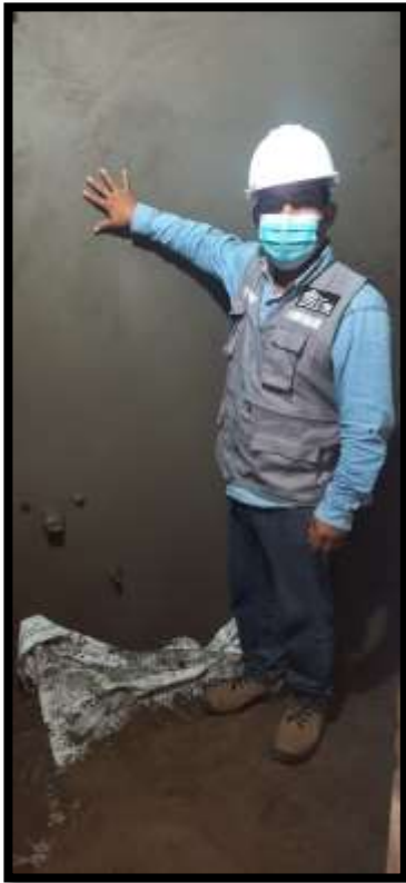
Fotografía 56: Tarrajeo de cielo raso
