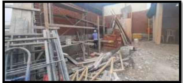
Fotografía 53: Inspeccionando los muros de ladrillo
