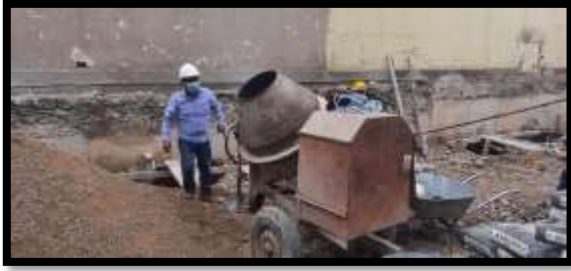
Fotografía 9: Inspeccionando la mezcla de concreto
