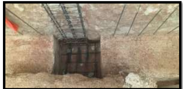
Fotografía 26: Plantado de Zapata y columna
