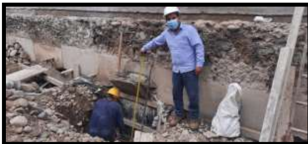
Fotografía 21: Desencofrado de calzada
