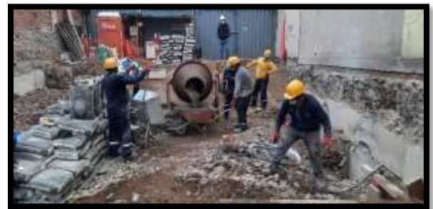
Fotografía 22: Preparación de concreto para calzada
