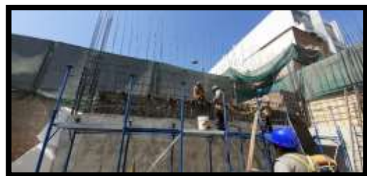
Fotografía 37: Armado de placas
