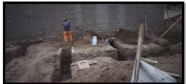
Fotografía 13: Excavación manual de zapatas y cimiento
