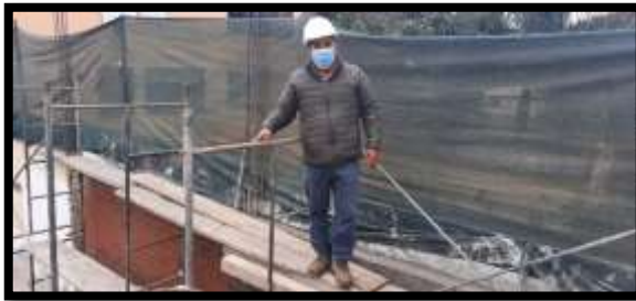
Fotografía 5: Revisando los andamios
