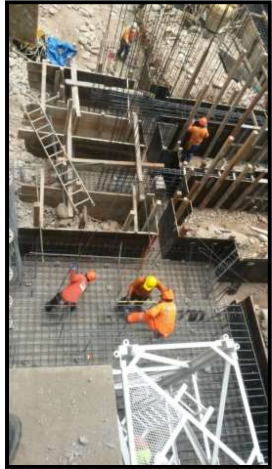
Fotografía 24: Armado de Zapata de ascensor
