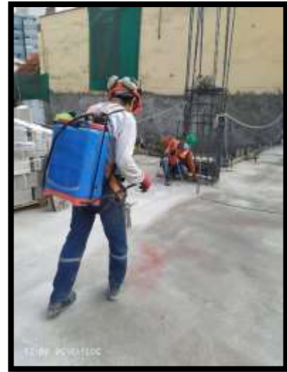
Fotografía 46: Curado de losa aligerada
