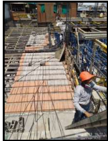
Fotografía 43: Ladrillos de arcilla en losa aligerada
