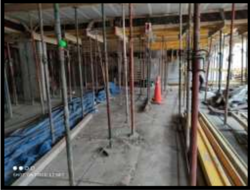
Fotografía 38: Encofrado de losa aligerada
