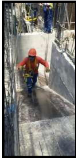
Fotografía 45: Fondo de escalera
