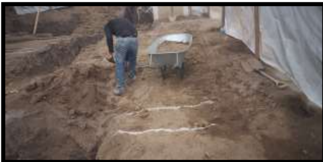
Fotografía 14: Acarreo manual de desmonte
