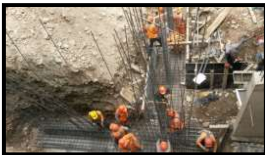
Fotografía 25: Armado de zapatas y columnas
