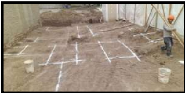
Fotografía 12: Trazo y replanteo
