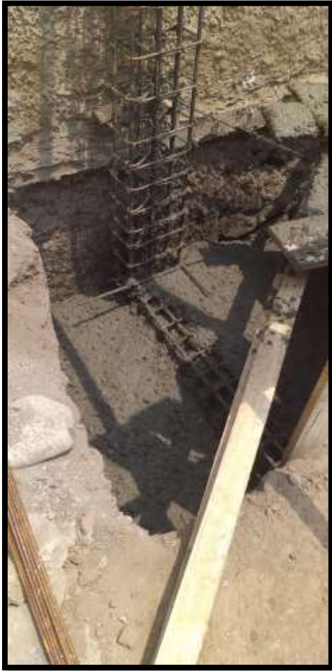
Fotografía 23: Vaciado de zapatas
