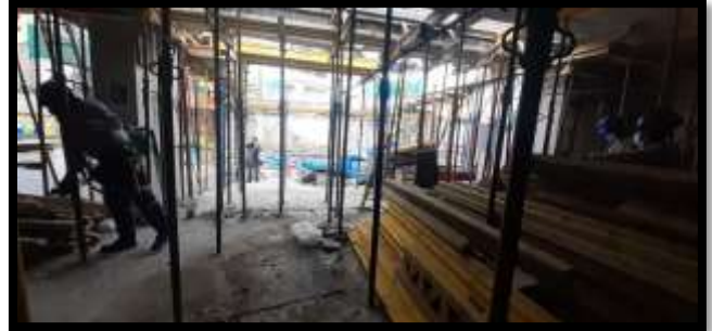
Fotografía 39: Encofrado de losa aligerada
