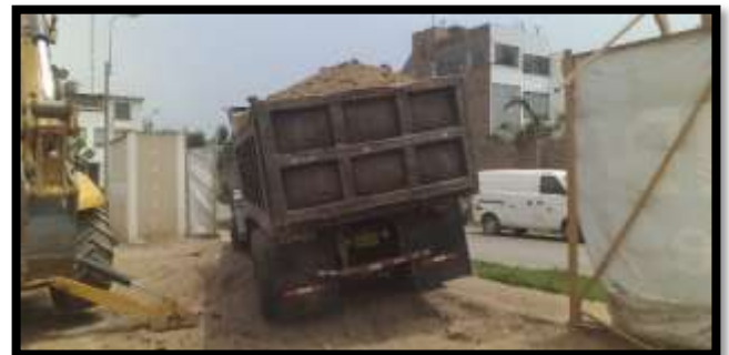
Fotografía 15: Eliminación de desmonte
