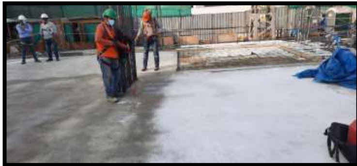
Fotografía 47: Curado de losa aligerada
