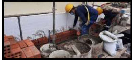
Fotografía 49: Asentado de ladrillo de sogá
