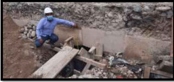
Fotografía 17: Encofrado de calzada
