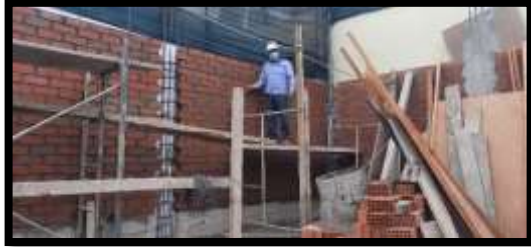
Fotografía 48: Revisión de la junta de los ladrillos
