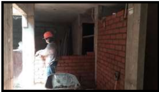
Fotografía 52: Asentado de muro en divisiones de sogá
