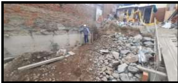
Fotografía 7: Inspeccionando los nieles de obra
