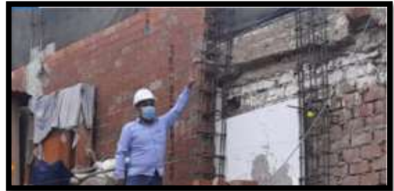
Fotografía 31: Confinamiento de estribos
