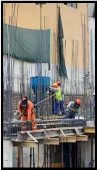
Fotografía 44: Enfierrado de viga
