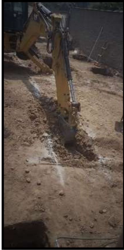
Fotografía 16: Excavación masiva con maquina
