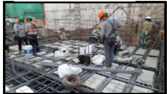
Fotografía 41: Colocación de puntos de electricidad
