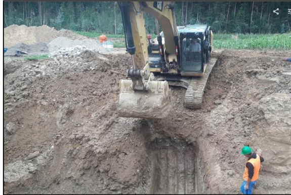
Figura 37: Excavación con excavadora en el lado sur.
