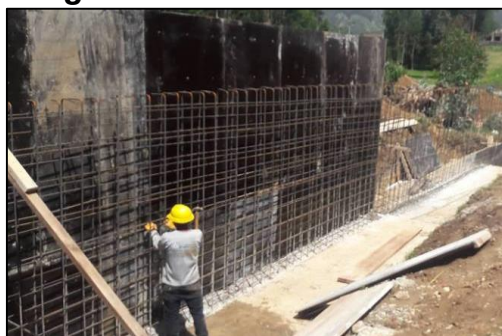
Figura 20: Armadura del muro.
