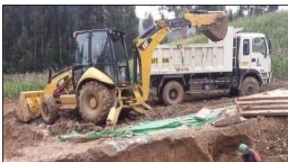
Figura 11: Eliminación de material.
