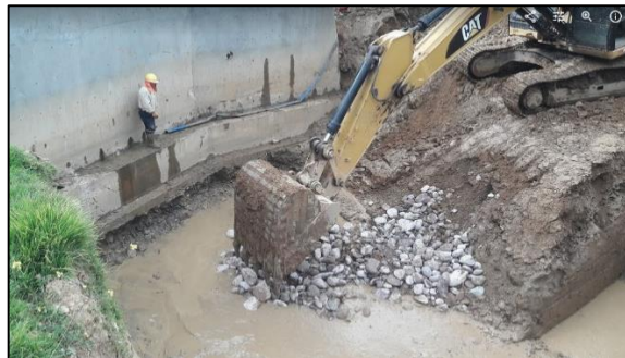
Figura 38: Uso de piedras para el solado en el lado sur.
