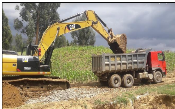
Figura 39: Eliminación de material.
