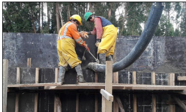
Figura 36: Vaceado de concreto de muros lado norte.
