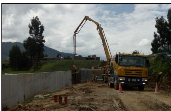
Figura 52: Llenado de concreto premezclado en los muros del lado norte.
