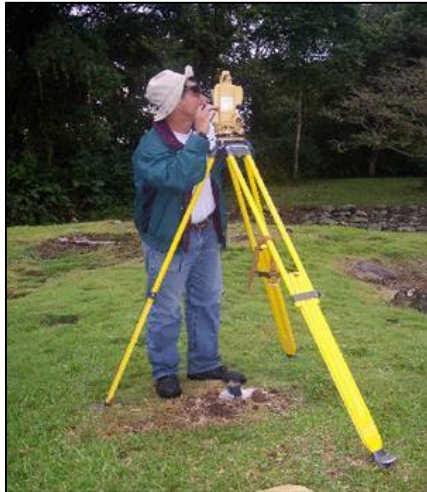
Figura 8: Control de niveles y coordenadas.
