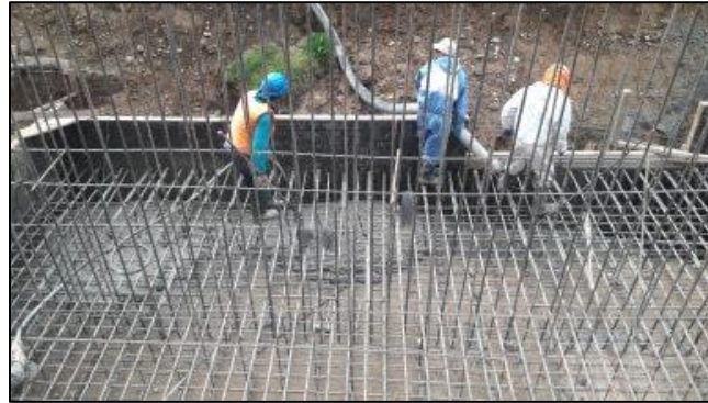
Figura 46: Concreto zapatas de los muros lado norte.
