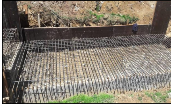
Figura 14: Colocación del encofrado de zapata.
