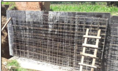
Figura 19: Encofrado del lado exterior.
