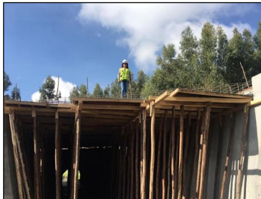
Figura 6: Construcción del Pontón N°2.
