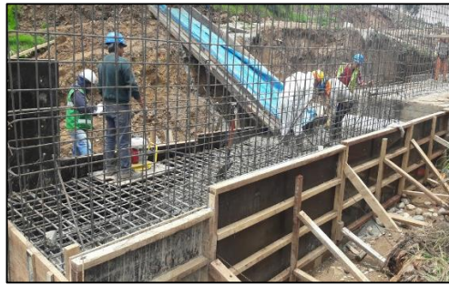
Figura 33: Concreto en zapatas.
