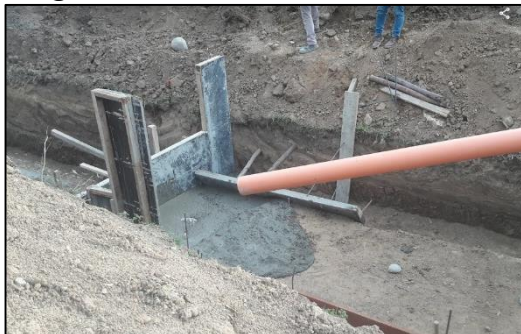
Figura 27: Solado muros de norte.
