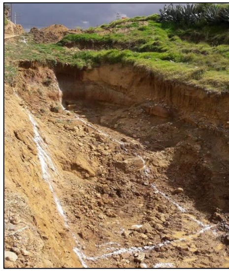
Figura 7: Trazo y replanteo del muro lado norte.
