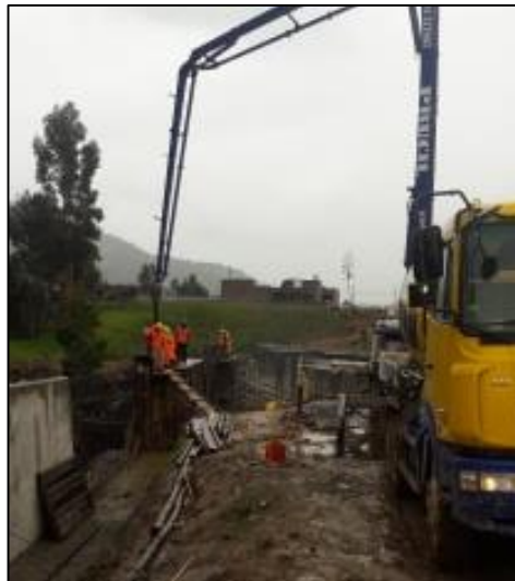
Figura 47: Concreto de los muros lado norte.
