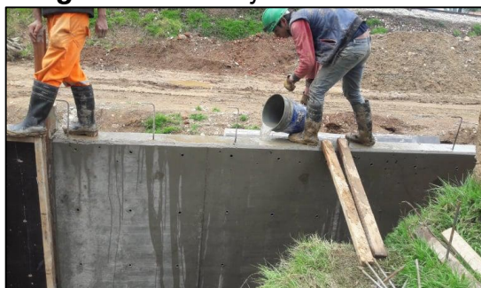
Figura 23: Drenaje de mechinales.
