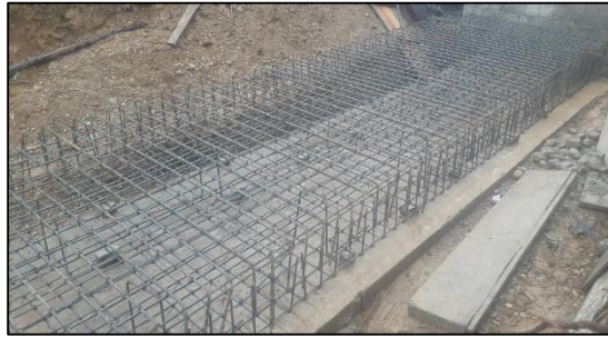
Figura 31: Acero en la zapata.
