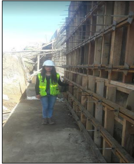
Figura 35: Encofrado de muros lado norte.
