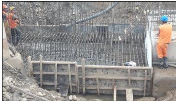
Figura 44: Acero y encofrado muros lado norte.
