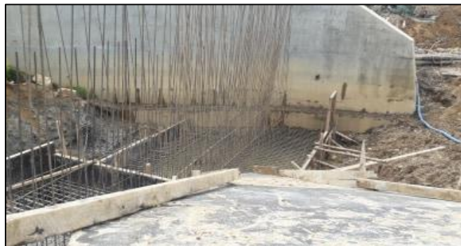
Figura 45: Acero y encofrado muros lado sur.
