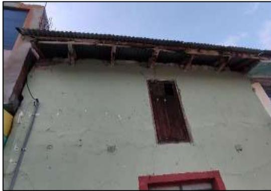
**Fotografía 11.** Mal conexión de la cobertura
