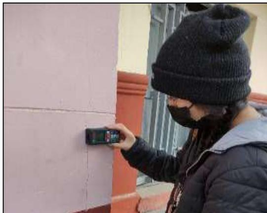
**Fotografía 9.** Tomando medidas de la vivienda 2 con el equipo medidor de distancia con láser BOSCH.
