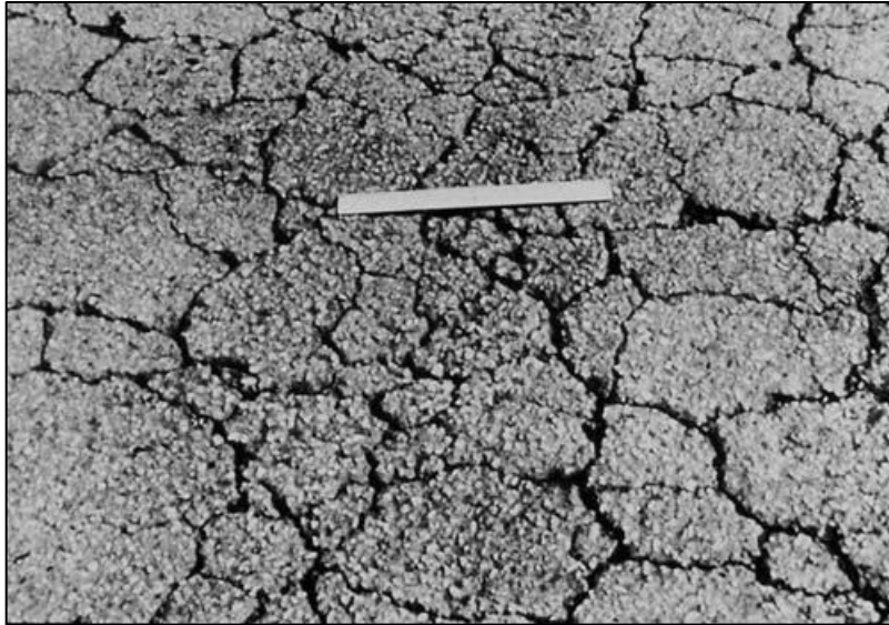
Figura 2: Piel de cocodrilo de alta gravedad Fuente: (ASTM Internacional , 2016)
