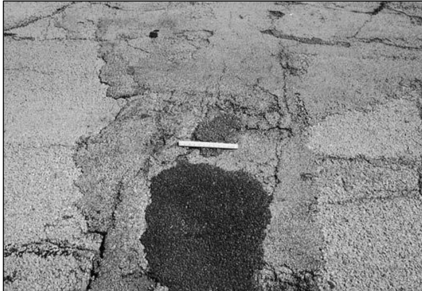
Figura 12: Parcheo de alta gravedad Fuente: (ASTM Internacional , 2016)
