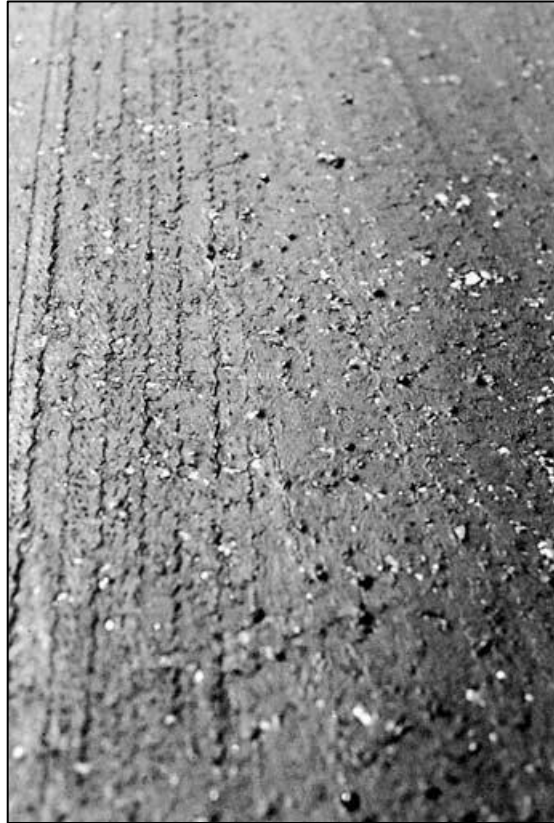
Figura 3: Exudación de alta gravedad (ASTM Internacional , 2016)
