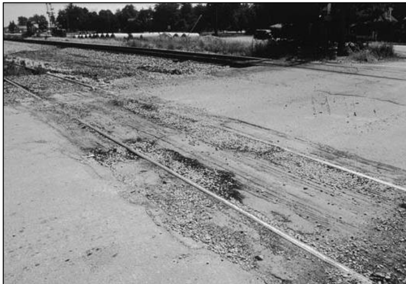
Figura 15: Cruce de vía férrea de alta gravedad Fuente: (ASTM Internacional , 2016)
