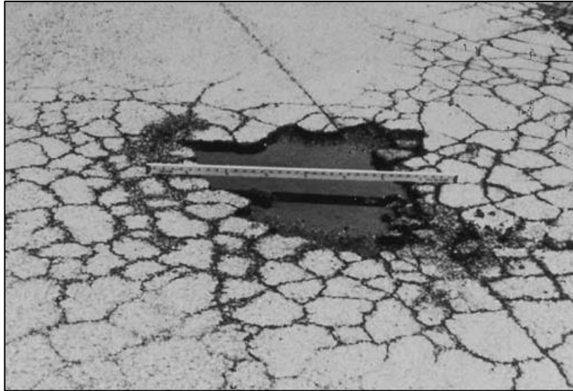
Figura 14: Hueco de alta gravedad Fuente: (ASTM Internacional , 2016)
