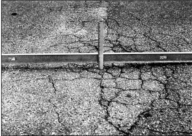
Figura 7: Depresión de alta gravedad Fuente: (ASTM Internacional , 2016)
