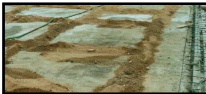
Figura 1: Curado de Concreto
