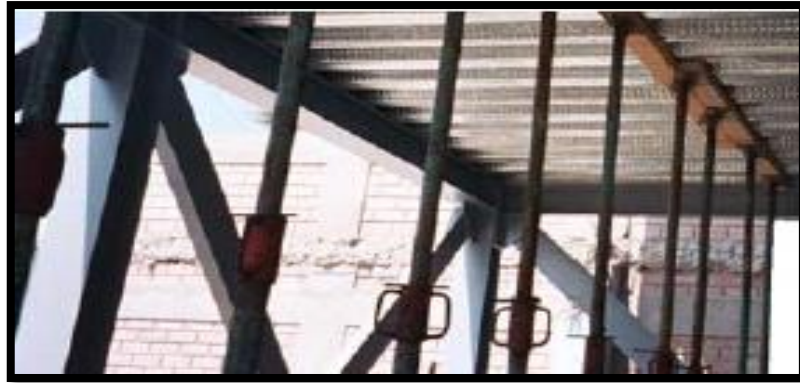
Figura 2: Desapuntalamiento de Placas Colaborantes
