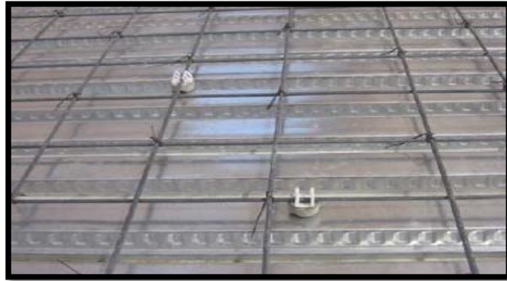
Figura 6: Colocación de acero de temperatura
