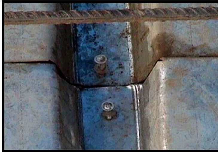
Figura 5: Fijación de placas colaborantes
