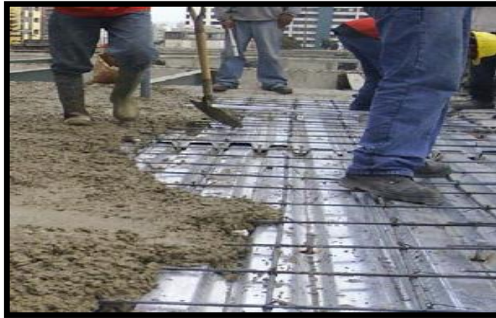
Figura 7: Vaciado de Concreto
