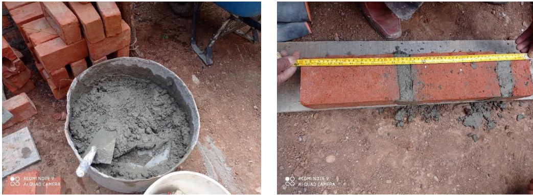
Figura 33: Construcción de muretes
