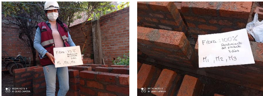
Figura 34: Construcción de pilas
