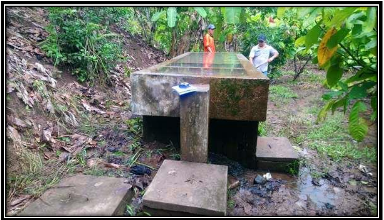
Fotografia Nro.2 Revision del desarenador.
