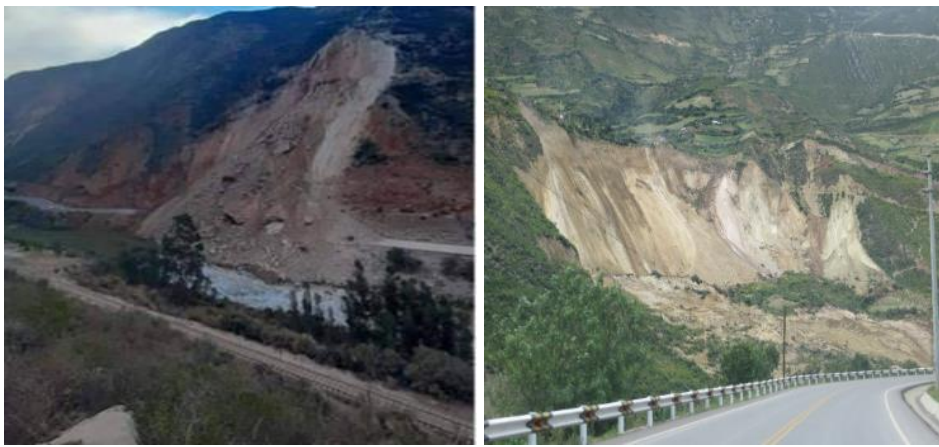
Figura 1: Deslizamiento de taludes tanto en la margen derecha e izquierda de la vía Izcuchaca – Huancavelica.
