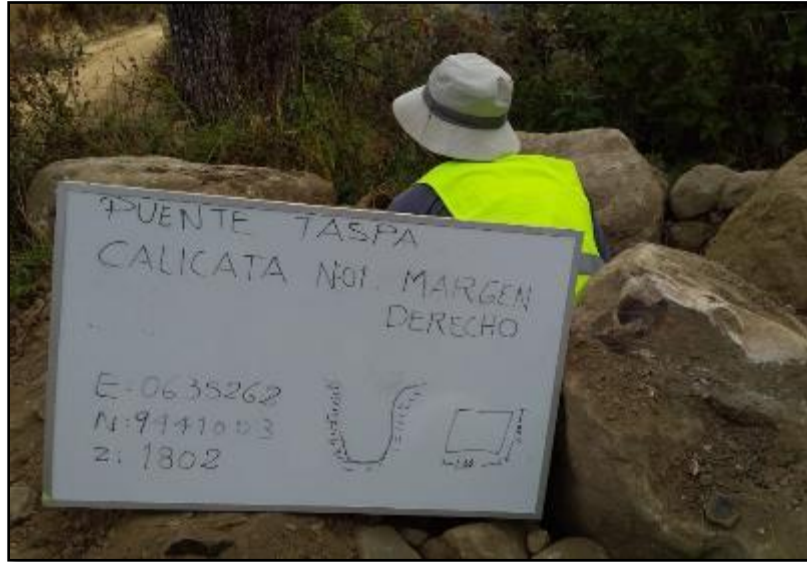
Calicata C-01 – Margen derecha
