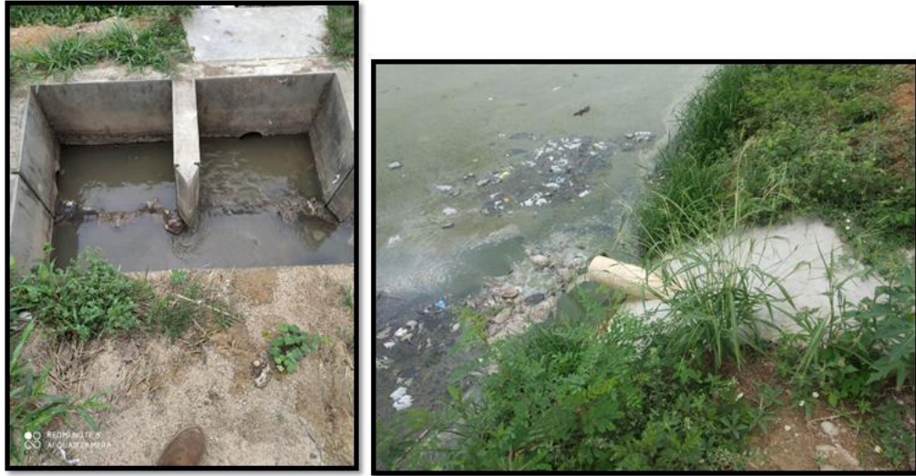
Figura 41 Descarga a la laguna en mal estado por la falta de una planta de tratamiento de agua residual
