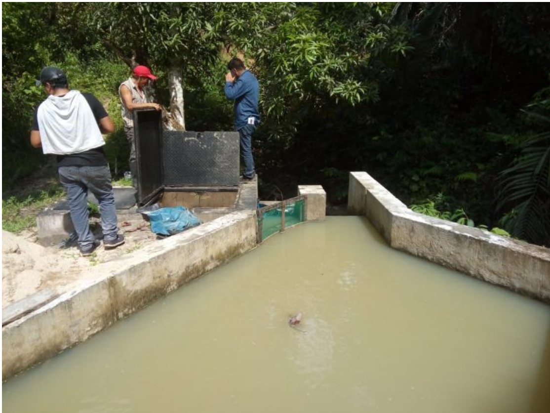
FOTOGRAFIAS DE LA CAPTACION EXISTENTE “SAN CRISTOBAL”
