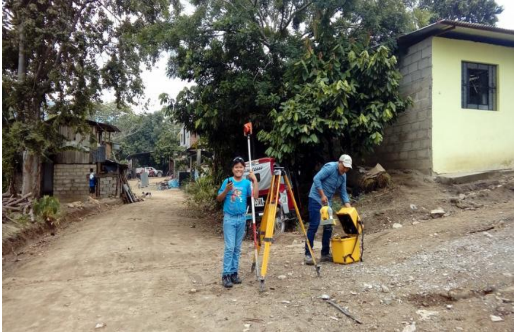
SE APRECIA EL PRECISO MOMENTO DONDE SE ESTA ESTACIONANDO LA ESTACION TOTAL
