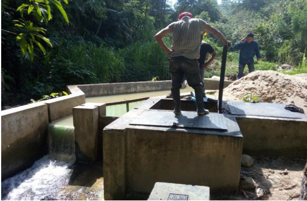
FOTOGRAFIAS DE LA CAPTACION EXISTENTE “SAN CRISTOBAL” – CAMARA HUMEDA
