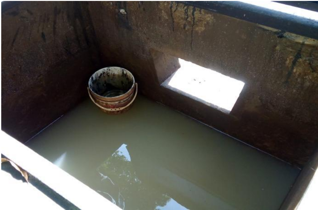
FOTOGRAFIAS DE LA CAPTACION EXISTENTE “SAN CRISTOBAL” – CAMARA HUMEDA
