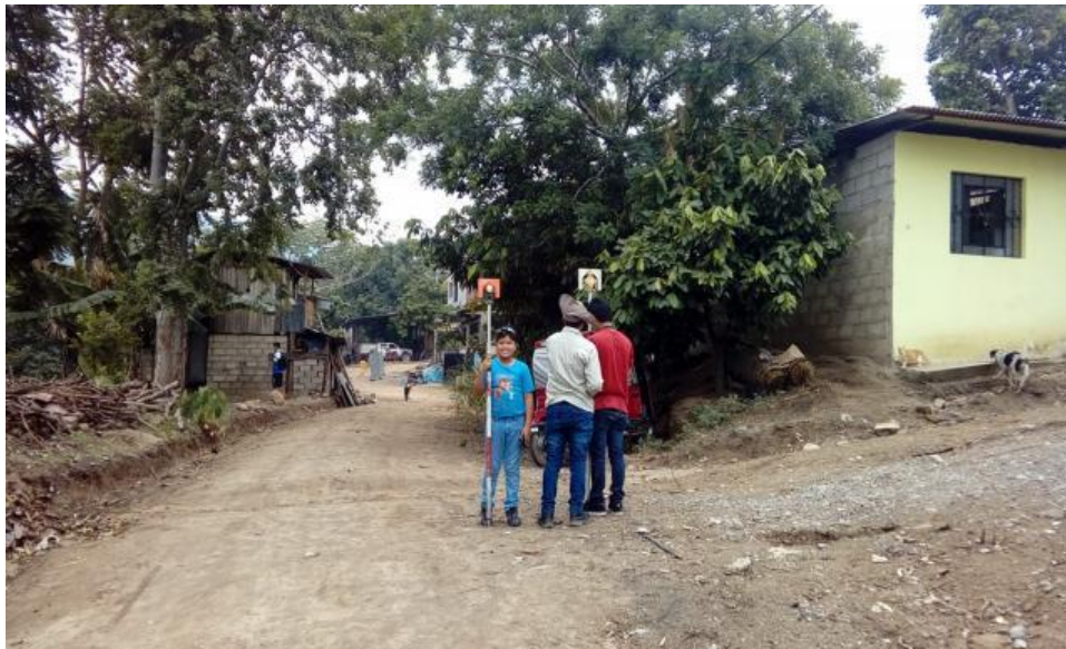
SE MIDE LA ALINEACION Y POSTERIOR CARRETERA PARA LA BUENA PROYECCION DEL PERFIL
