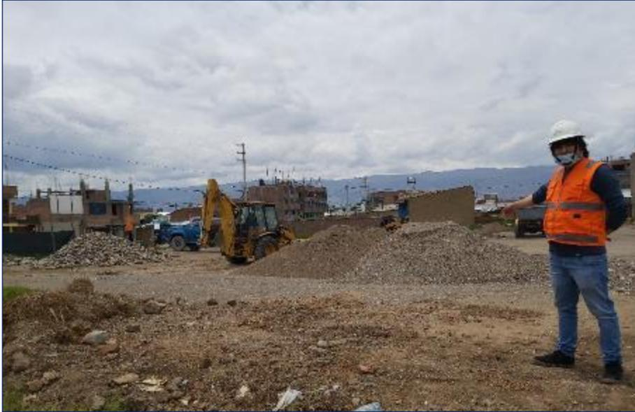
Fotografía 1. Vista de los agregados en cantera para su muestreo respectivo según la norma ASTM D75-03.
