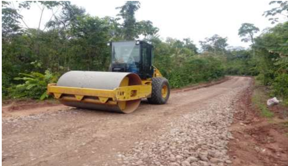
Figura N° 02: Conformado y compactado de carpeta de afirmado
