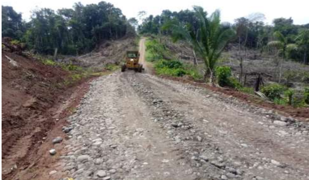
Figura N° 01: Conformación de carpeta de afirmado con material cantera Zanja Seca sin aporte de finos
