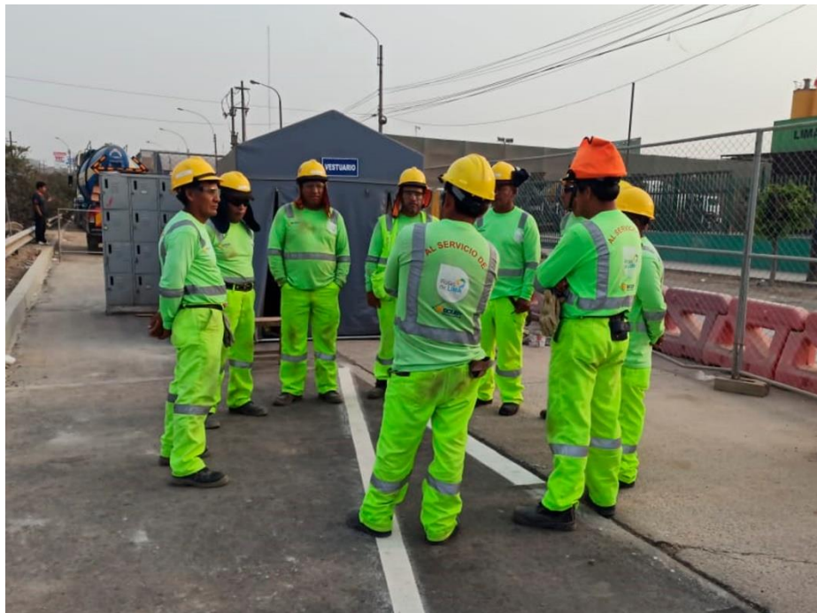
Figura 14. Cuadrilla de trabajo para pavimentación rígida
