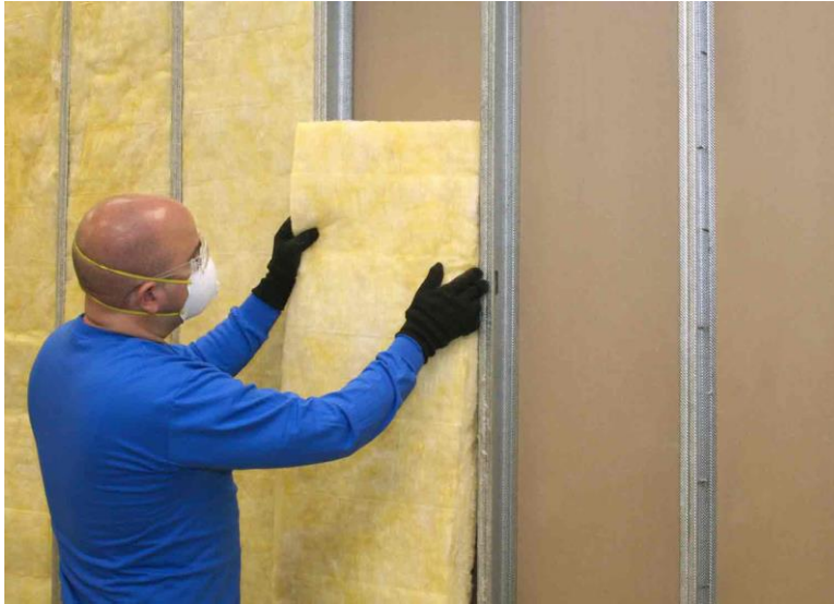
Figura 40. Colocado de la fibra de vidrio, aislamiento térmico del horno
