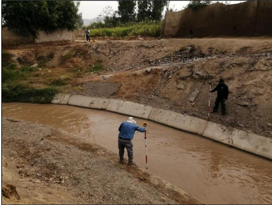
**Figura 8** Lectura con estación total en borde de canal
