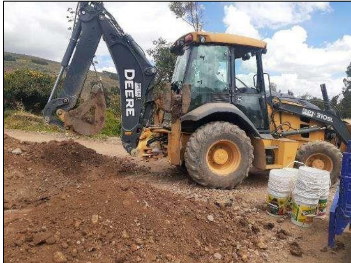
Fotografía 1. Excavación de las calicatas para la obtención de muestras.
