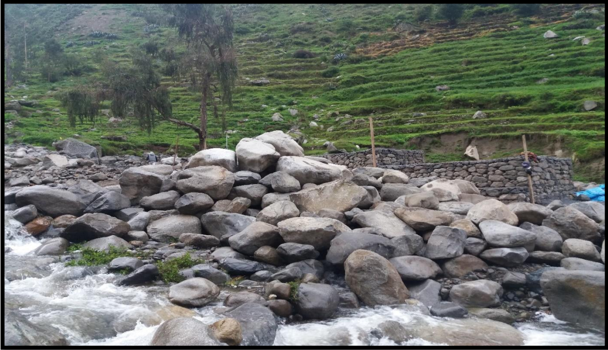
acopio de roca para el armado de los cajones de gaviones
