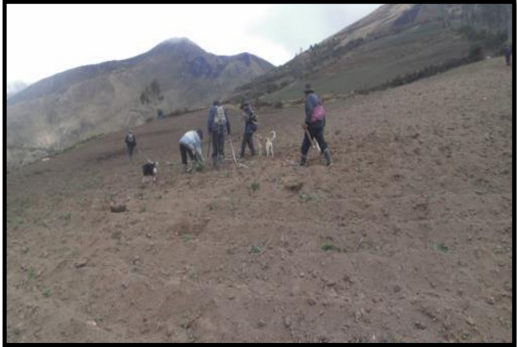
IMAGEN 3: Se aprecia el estacado del eje de vía de la carretera.
