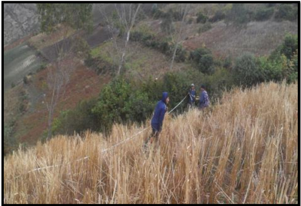
IMAGEN 5: En esta vista se aprecia el trazado del eje de vía de la carretera.
