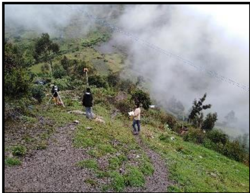
IMAGEN 2: Levantamiento topográfico (km 0+500)
