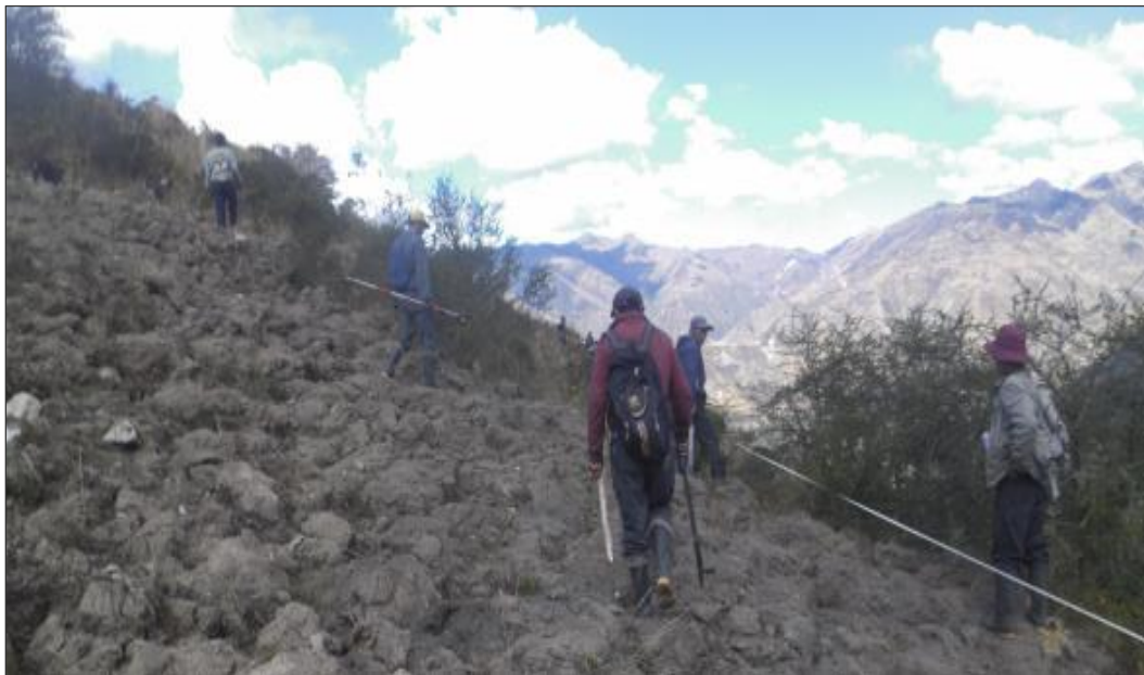
Figura 17 Se observa el trabajo del trazo preliminar del eje de la vía
