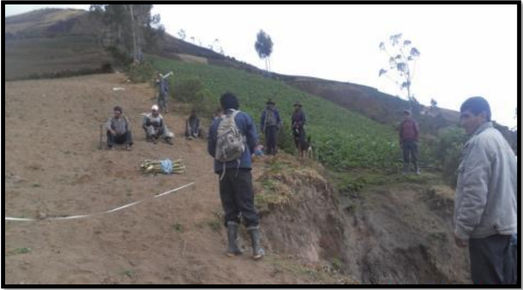
IMAGEN 5: En esta vista se aprecia el trazado del eje de vía de la carretera
