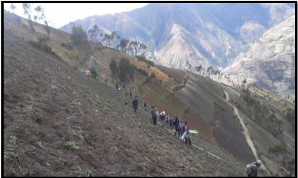
IMAGEN 4: Se aprecia el estacado del eje de vía de la carretera.
